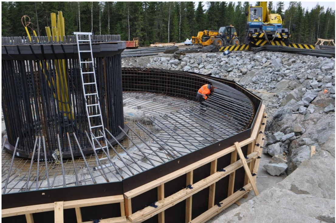
Kuva 5-5. Tuulivoimalan perustusten rakentamista. (Kuva: Leila Väyrynen, FCG)
