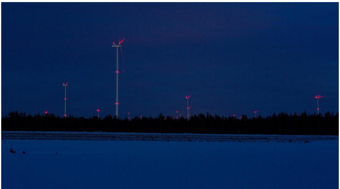
Kuva 5.3. Kiinteät punaiset lentoestevalot. (Kuvat: Ville Suorsa, FCG)
