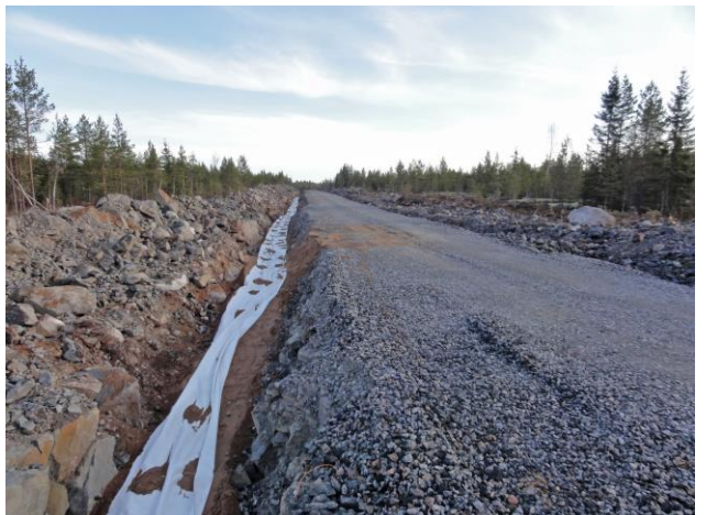
Kuvapari 5.8. Maakaapelit upotetaan huoltoteiden yhteyteen (kuvat: Ville Suorsa/FCG).
