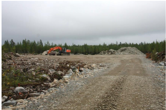
Kuvapari 5.7. Tuulivoimapuiston rakentaminen alkaa huoltoteiden ja pystytysalueiden rakentamisella (kuvat: Ville Suorsa, FCG).
