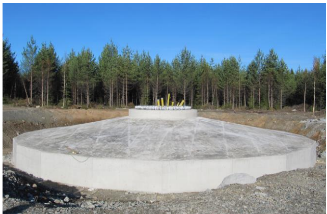
Kuvapari 5.9. Tuulivoimalan perustusten rakentamista. (Kuvat: Leila Väyrynen, FCG)
