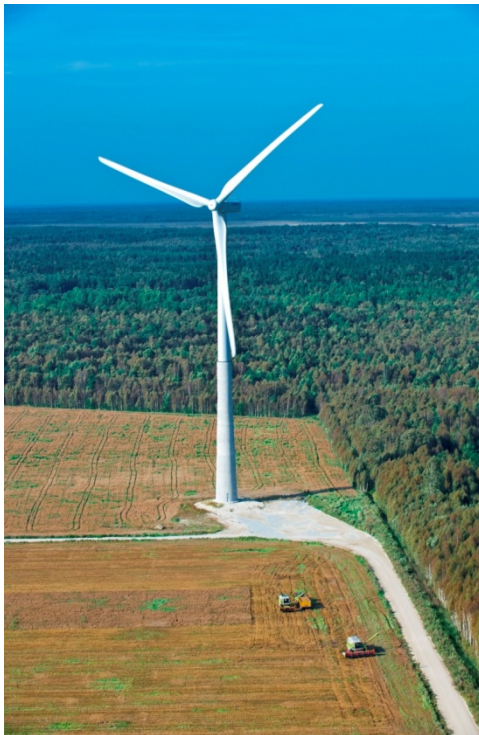
Kuva 4-1. Vasemmalla 3 MW:n tuulivoimalaitos, jonka tornin alaosa on betonia ja yläosa terästä, napakorkeus ja roottori ovat 100 m (Kuva: WinWinD). Oikealla on periaatekuva tuulivoimalasta (Kuva: planete-energies.com).
