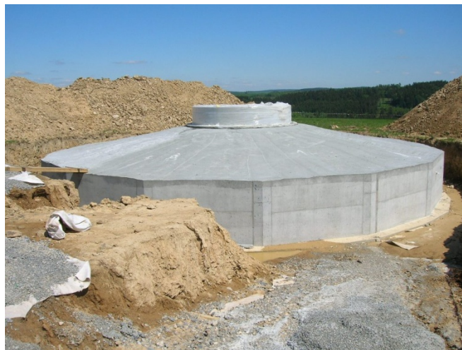
Kuva 4-1. Tuulivoimalan betonilaatta ennen sen peittämistä maa-aineksilla. Kuva: Vetrna energie HL ( www.vehl.cz )
