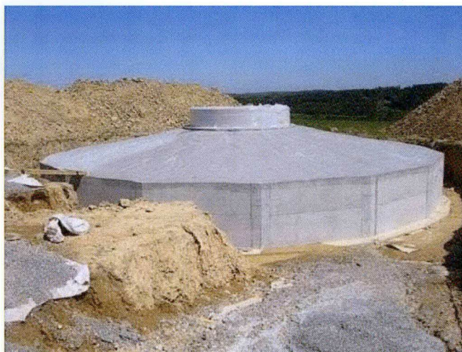
Kuva 4-6. Tuulivoimalan betonilaatta ennen sen peittämistä maa-aineksilla (kuva: Vetna energie HL www.vehl.cz ).
