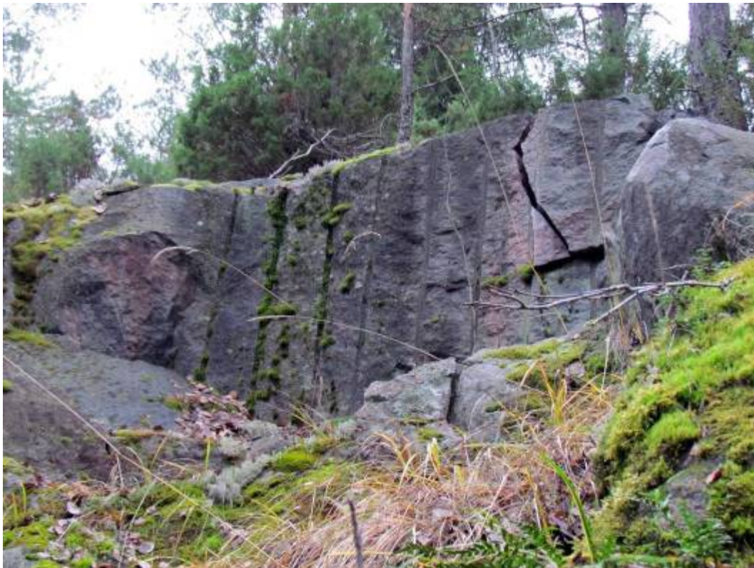
Kuva 12-2. Selvitysalueen maastossa oli selkeästi näkyvissä alueella aiemmin tehtyjen louhintatöiden jäljet. Kuvan kalliossa näkyy aiempia osin sammalen peittämiä poraus- ja räjäytysjälkiä.
