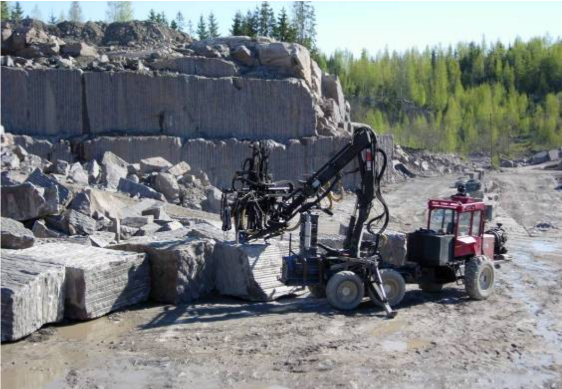
Kuva 6-3. Lohkareiden paloittelu (© Palin Granit Oy).
