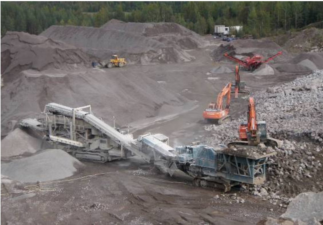
Kuva 6-7. Siirrettävä murskauslaitos ja murskeen syöttö laitokseen kaivinkoneella sekä valmiiden tuotteiden varastokasoja hankealueella.
