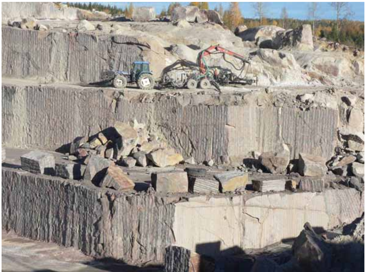
Kuva 5. Kallion vaakaporaus kamin irrottamiseksi
