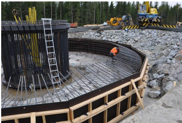
Kuvapari 5-10. Tuulivoimalan perustusten rakentamista. (Kuvat: Leila Väyrynen, FCG)
