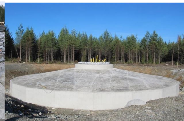
Kuvapari 5-10. Tuulivoimalan perustusten rakentamista. (Kuvat: Leila Väyrynen, FCG)
