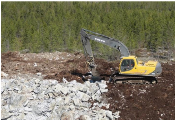
Kuvapari 5-8. Tuulivoimapuiston rakentaminen alkaa huoltoteiden ja pystytysalueiden rakentamisella (kuvat: Ville Suorsa, FCG).
