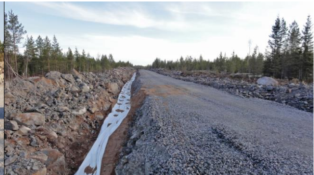
Kuvapari 5-9. Maakaapelit upotetaan huoltoteiden yhteyteen (kuvat: Ville Suorsa/FCG).
