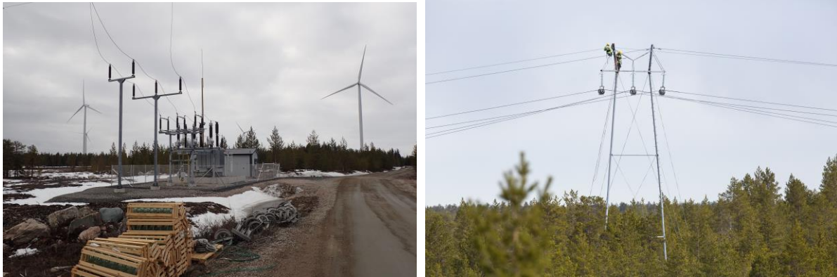
Kuvapari 5-13. Sähköaseman ja voimajohdon rakentamista. (Kuvat: Ville Suorsa, FCG)
