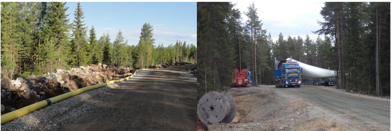
Kuva 5-5. (Vasemmalla) Esimerkki tuulivoimapuiston rakennus- ja huoltotiestä. Teitä käytetään muun muassa betonin, soran ja voimaloiden komponenttien kuljetuksiin sekä tuulivoimapuiston käyttövaiheessa
