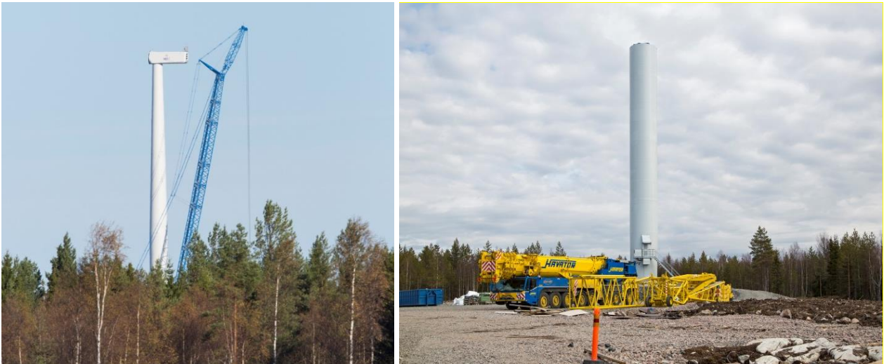
Kuvapari 5-11. Tuulivoimalan kokoamista. (Kuvat: Ville Suorsa, FCG)
