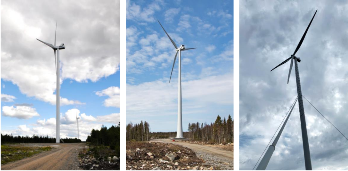
Kuva 5-1. Vasemmalla on esimerkki teräslieriötornista, keskellä hybriditornista ja oikealla harustetusta tornista. (Kuvat: Leila Väyrynen ja Ville Suorsa, FCG sekä Jarkko Finnilä, Carelin)
