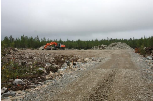
Kuvapari 5-8. Tuulivoimapuiston rakentaminen alkaa huoltoteiden ja pystytysalueiden rakentamisella (kuvat: Ville Suorsa, FCG).
