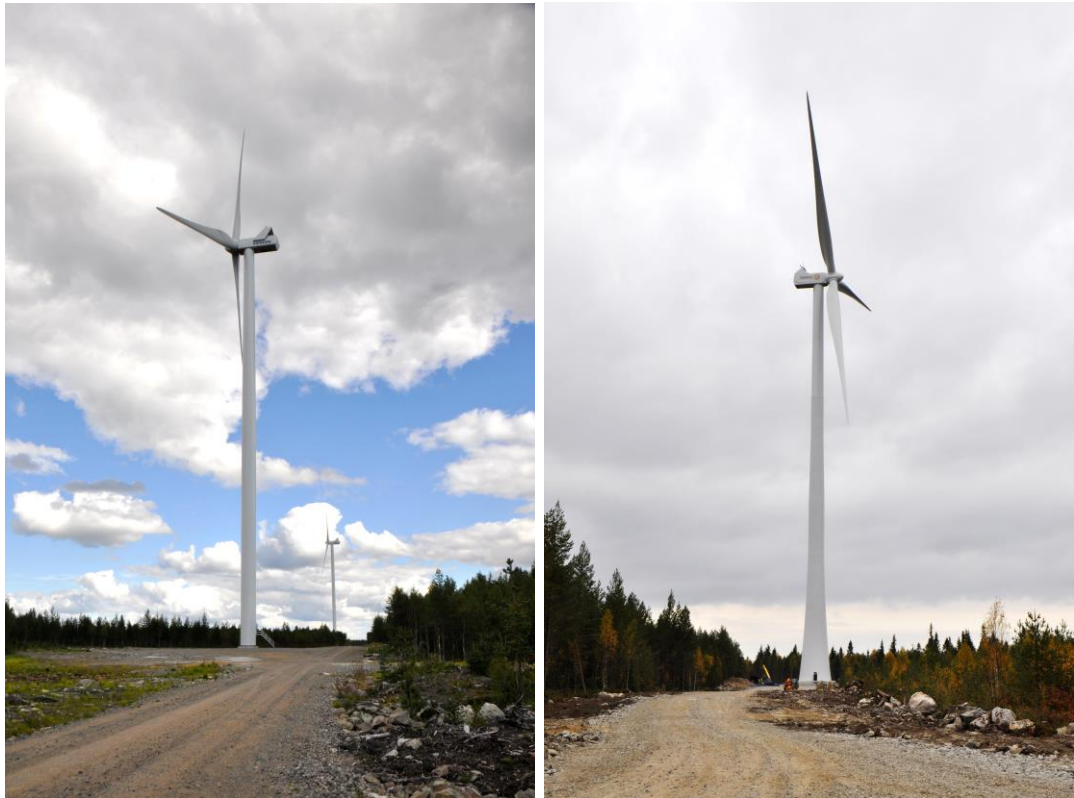
Kuva 5.1. Vasemmalla on esimerkki teräslieriötornista ja oikealla rakenteilla olevasta hybriditornista. (Kuvat: Leila Väyrynen, FCG)
