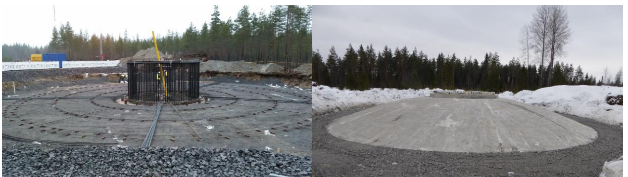
Kuvapari 5.10. Tuulivoimalan perustusten rakentamista. (Kuvat: TM Voima Oy / Pajukoski I työmaa)
