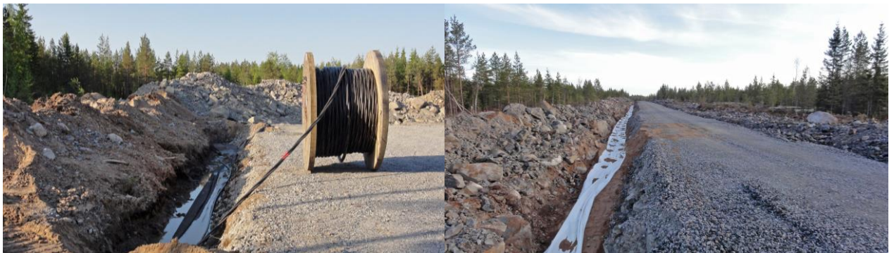
Kuvapari 5.8. Maakaapelit upotetaan huoltoteiden yhteyteen (kuvat: Ville Suorsa/FCG).
