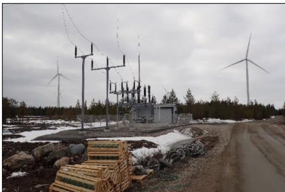
Kuvapari 5.14. Sähköaseman rakentamista. (Kuva: Ville Suorsa, FCG)
