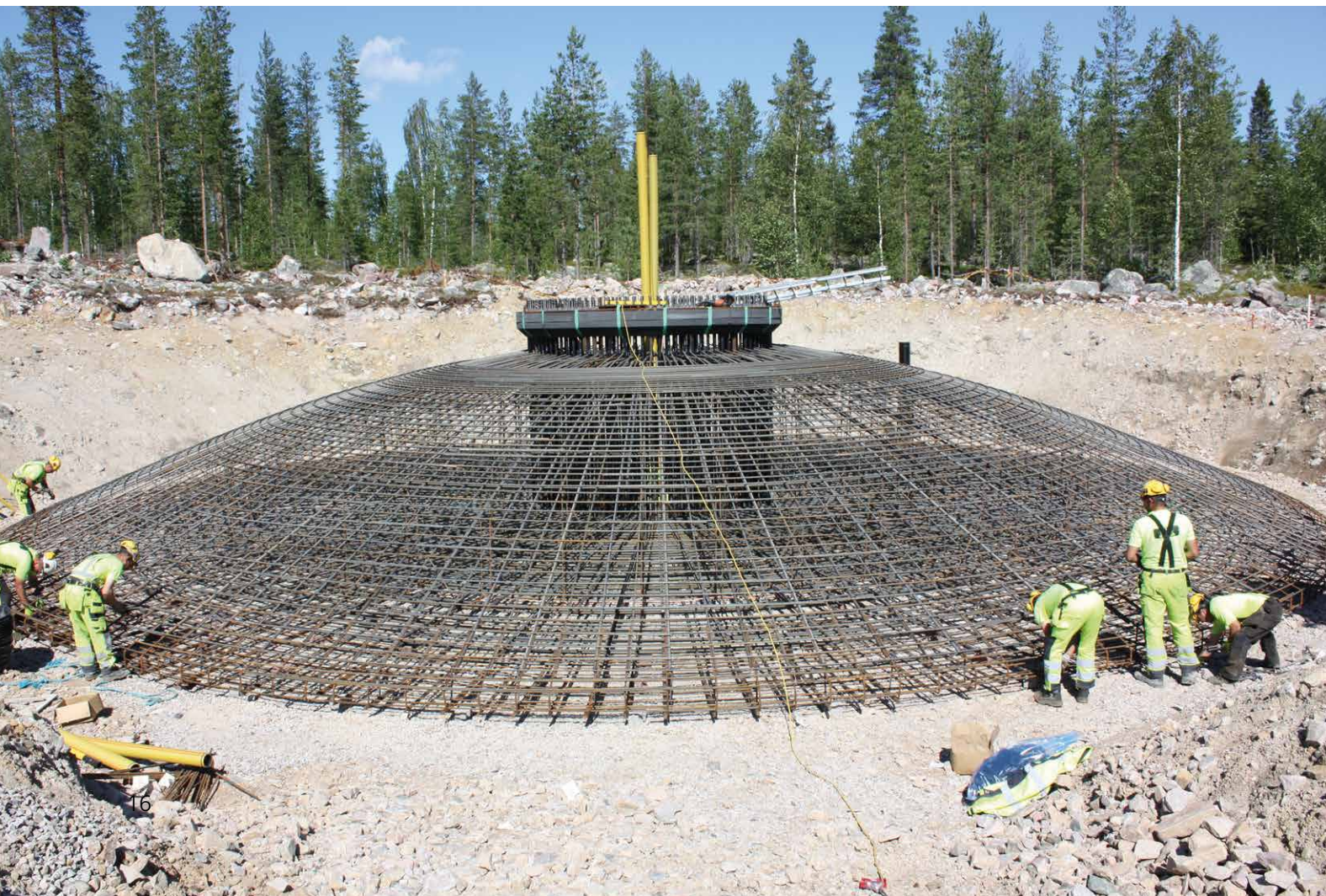
Kuva 4-5. Maanvarainen teräsbetoniperustus raudoitettuna ennen betonivalua.
