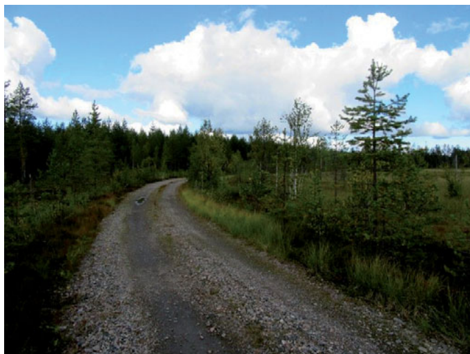
Kuva 9. Tielinjaus Kuivauslammen lounaispuolella kuvattuna pohjoiseen.
