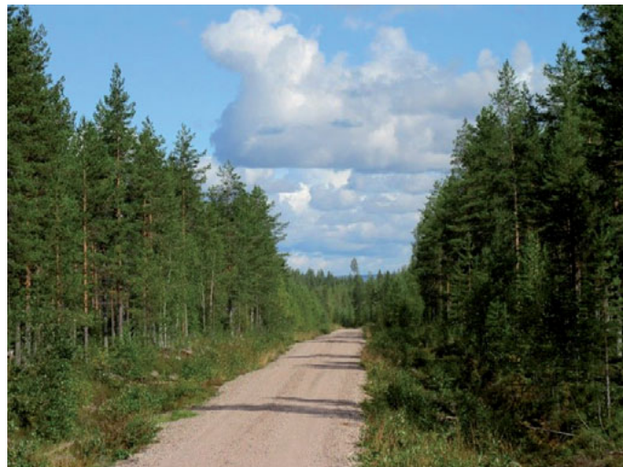
Kuva 30. Tielinjaus hankealueen pohjoisosassa kuvattu koilliseen.
