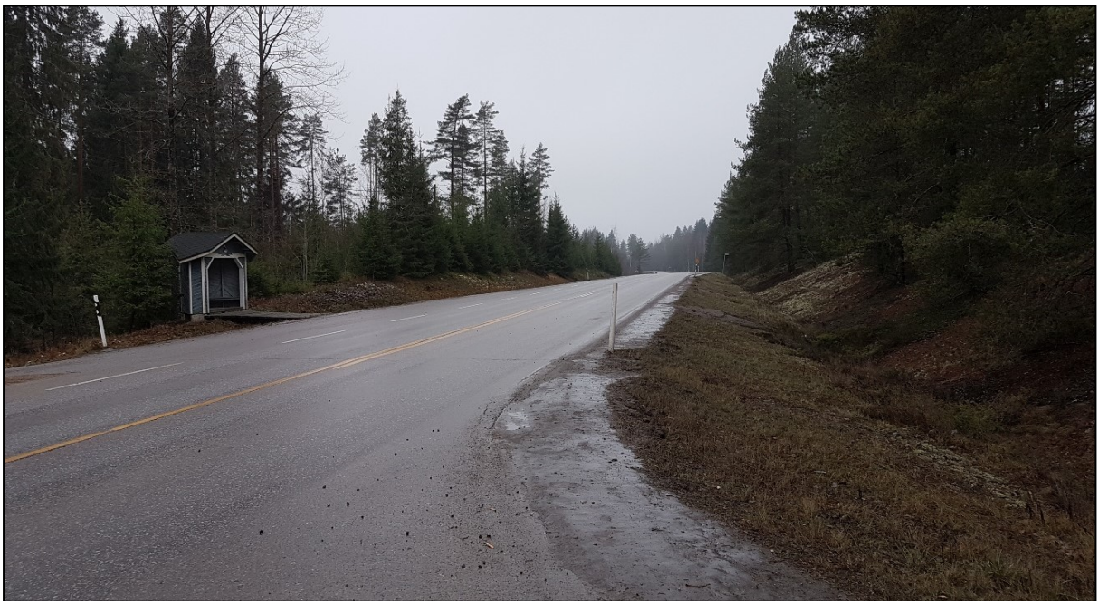
Kuva 49. Padasjoentie Mustajärventien liittymästä Hämeenlinnaan päin kuvattuna.
