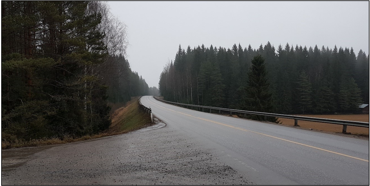
Kuva 48. Padasjoentie Mustajärventien liittymästä Padasjoelle päin kuvattuna.
