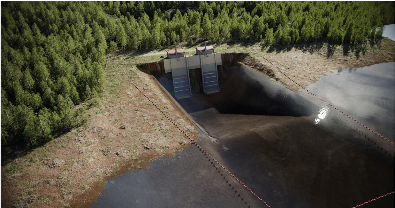
Kuva 2-13. Havainnekuva purkurakenteesta TVE1/TVE3.
