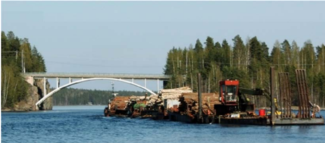
Kuva 109. Puukuorma alittamassa Kirjamoinsalmen siltaa.
