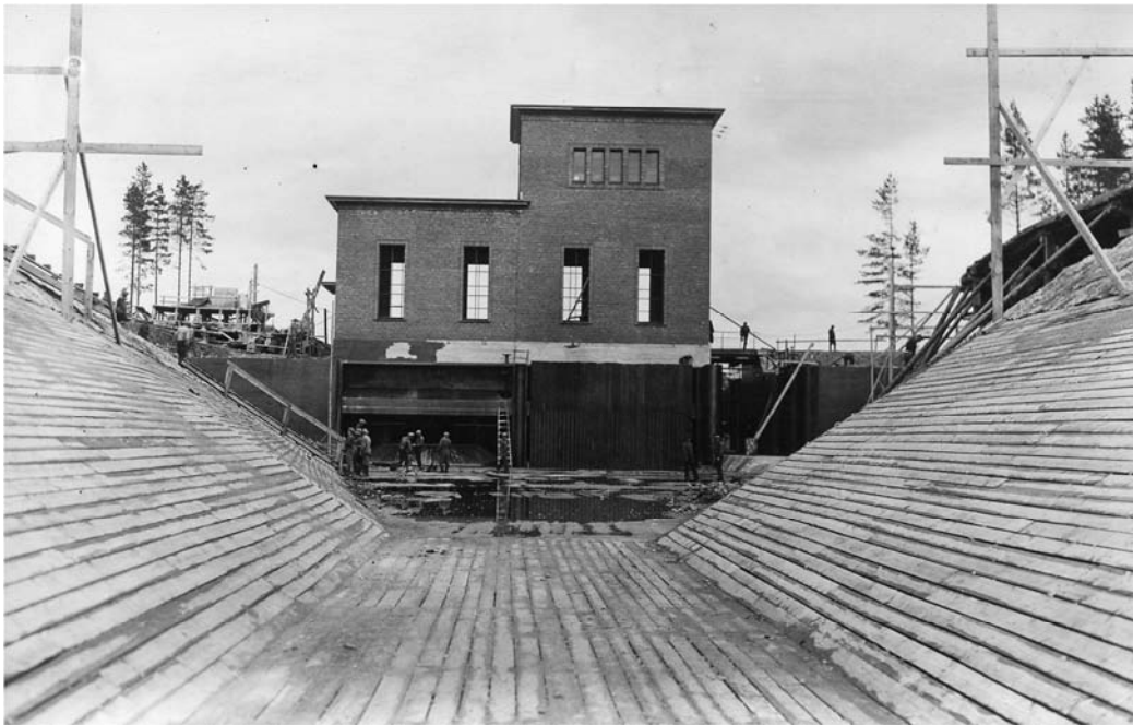
Kuva 44. Rakennusaikainen kuva Vehkataipaleen pumppulaitoksesta. (Kaukaan arkisto)
