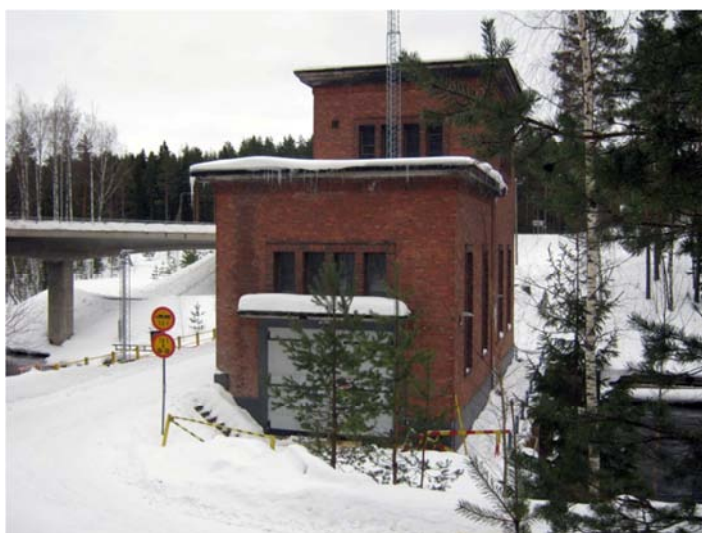
Kuva 105. Vehkataipaleen pumppuasema kanavan pohjoispuolelta nähtynä. Uusien pumpppujen myötä muutokset kohdistuvat pumppuaseman pohjoispuolelle, kuvan etualalle. Yksityiskohtaisessa suunnittelussa uudet rakenteet tulee pyrkiä sovittamaan erityisen huolella tähän maakunnallisesti arvokkaaseen kokonaisuuteen.
