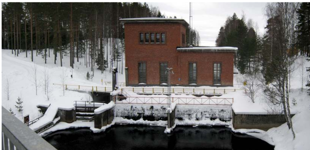
Kuva 104. Vehkataipaleen pumppuasema. Suunnitelmassa uudet pumpput sijoittuvat kuvassa oikealla näkyvän betonirakenteen kohdalle. Kanavan pohjoisrantaa joudutaan muotoilemaan uudestaan pumpppujen kohdalta ja lyhyeltä matkalta itään päin.
