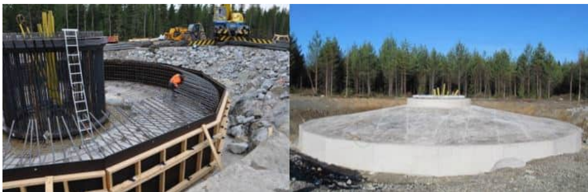
Kuva 4.11 Tuulivoimalan perustusten rakentamista (FCG Finnish Consulting Group Oy).
