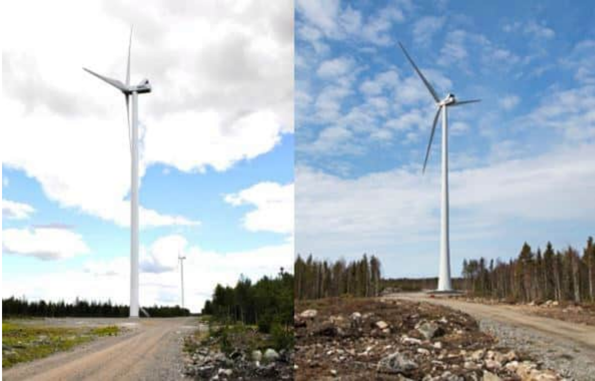
Kuva 4.2 Vasemmalla on esimerkki teräslieriötornista ja oikealla hybriditornista (FCG).
