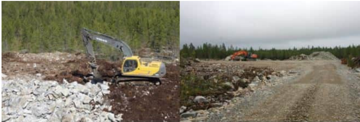
Kuva 4.9 Tuulivoima-alueen rakentaminen alkaa huoltoteiden ja pystytysalueiden rakentamisella (FCG Finnish Consulting Group Oy).
