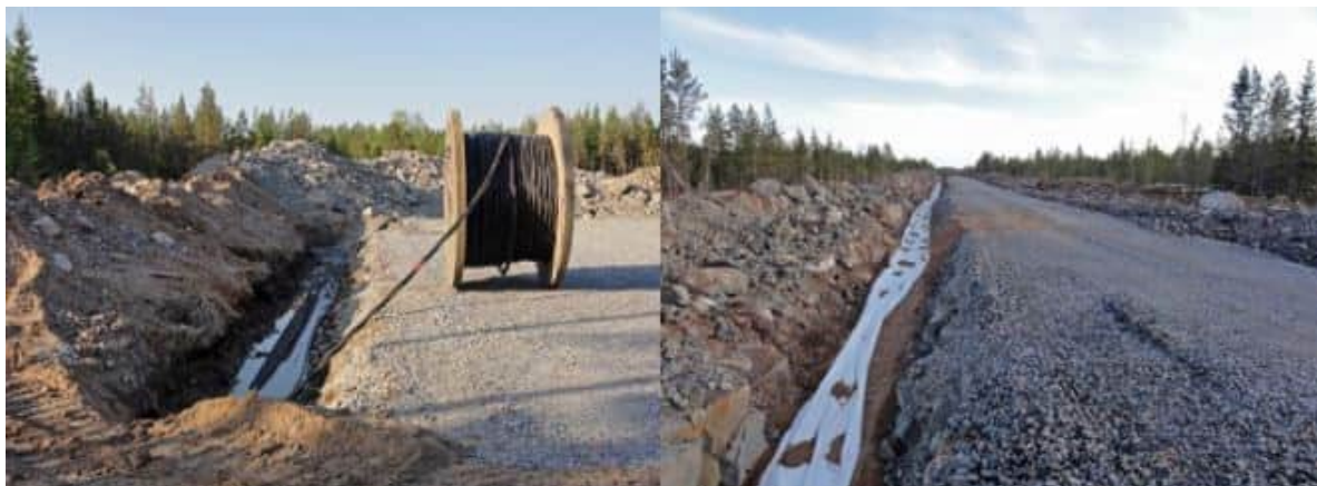
Kuva 4.10 Maakaapelit upotetaan huoltoteiden yhteyteen (FCG Finnish Consulting Group Oy).
