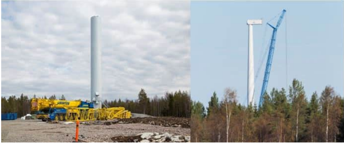
Kuva 4.12 Tuulivoimalan kokoamista (FCG Finnish Consulting Group Oy).
