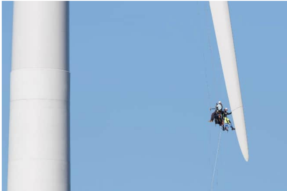
Kuva 4.16 Tuulivoimalan huoltotoimenpiteitä (FCG Finnish Consulting Group Oy).
