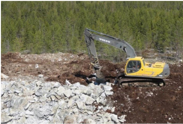
Kuva 22. Tuulivoimahankkeen rakentaminen alkaa huoltoteiden ja pystytysalueiden rakentamisella. (Kuvat: FCG)
