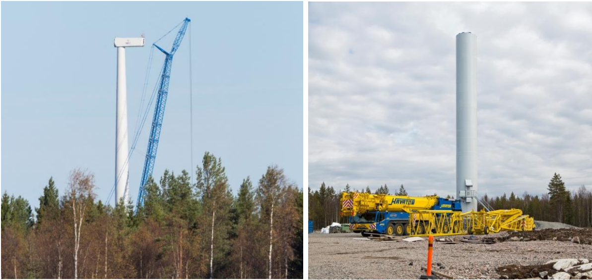
Kuva 25. Tuulivoimalan kokoamista. (Kuvat: FCG)
