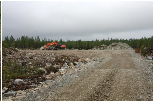
Kuva 22. Tuulivoimahankkeen rakentaminen alkaa huoltoteiden ja pystytysalueiden rakentamisella. (Kuvat: FCG)
