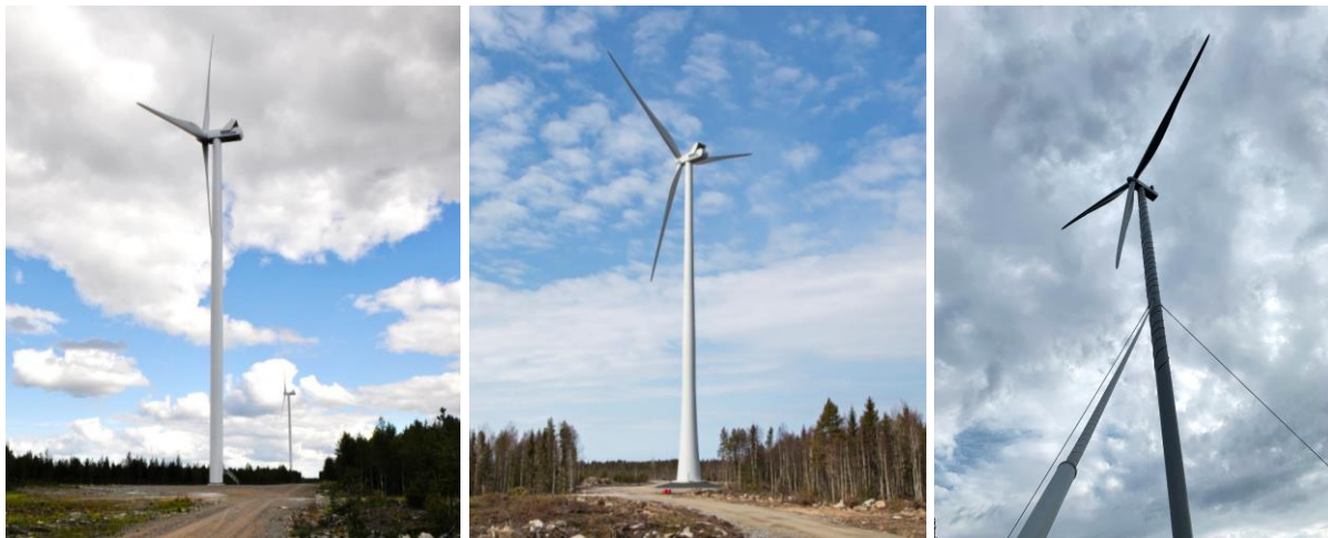
Kuva 13. Vasemmalla on esimerkki teräslieriötornista, keskellä hybriditornista ja oikealla harustetusta tornista. (Kuvat: FCG sekä Jarkko Finnilä, Carelin)
