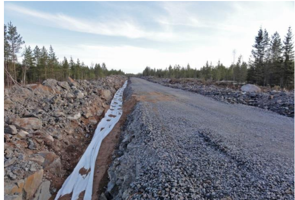
Kuva 23. Maakaapelit upotetaan huoltoteiden yhteyteen. (Kuvat: FCG)
