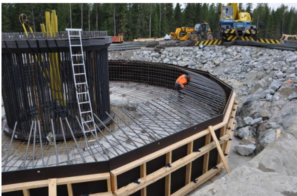
Kuva 24. Tuulivoimalan perustusten rakentamista. (Kuvat: FCG)
