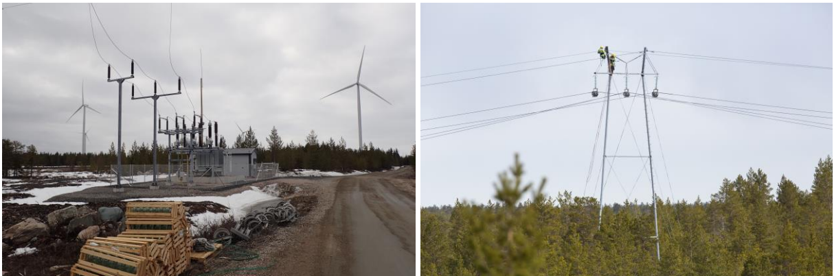
Kuva 27. Sähköaseman ja voimajohdon rakentamista. (Kuvat: FCG)
