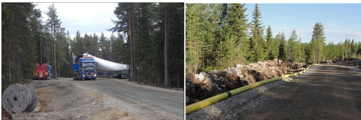
Kuva 18. (Vasemmalla) Esimerkki tuulivoimahankealueen rakennus- ja huoltotiestä. Teitä käytetään muun muassa betonin, soran ja voimaloiden komponenttien kuljetuksiin sekä tuulivoimahankealueen käyttövaiheessa huoltoajoihin. Maakaapeli sijoitetaan ojakaivantoon tien reuna-alueelle. (Oikealla) Tuulivoimalan osia kuljetetaan erikoiskuljetuksina. (Kuvat: FCG).
