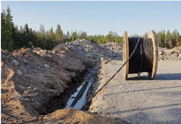
Kuva 23. Maakaapelit upotetaan huoltoteiden yhteyteen. (Kuvat: FCG)
