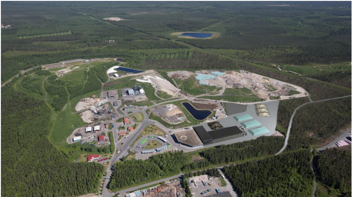
Kuva 26. Kuvasovite jätteen hankevaihtoehdon VE2 mukaisesta jätteen mekaanisen lajittelulaitoksen yhdestä lajittelulinjasta sekä varastoista Ruskon jätekeskuksen alueella kuvattuna etelästä. Hankevaihtoehdossa VE2 yhdyskuntajätteen mekaaninen lajittelulinja ja biojätteen käsittelylaitos sijoitetaan Laanilan teollisuusalueelle (kuva 27).
