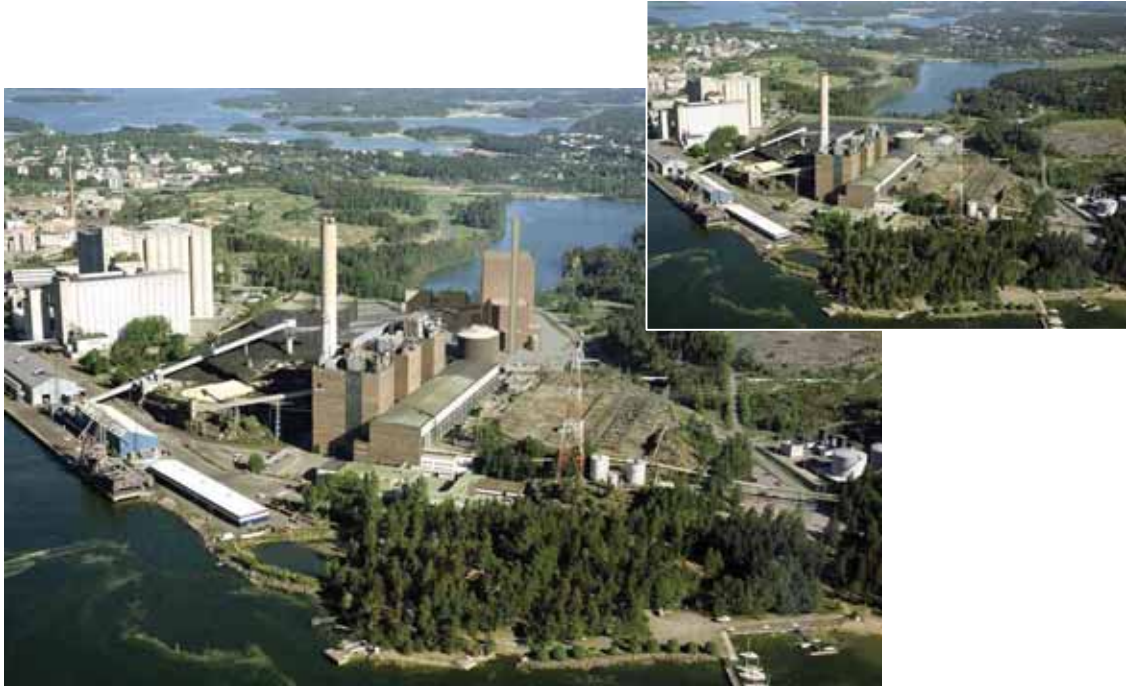
Kuva 8-15. Suurempi kuva: Viistoilmakuvasovite, VE1. Pienempi kuva: Alueen nykytila. Viistoilmakuvasovitteessa esitettyjen uusien rakennusten ja rakenteiden sijainti ja mitoitus perustuu alustaviin teknisiin suunnitelmiin. Uusien rakennusten ulkonäkö on viitteellinen, sillä rakennusten varsinaista suunnittelua (mm. arkkitehtisuunnittelu) ei ole vielä käynnistetty.
