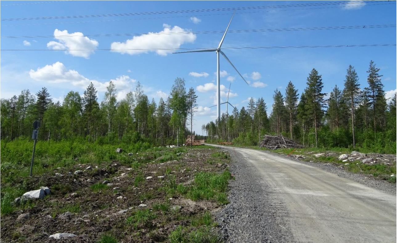
Kuva 19. Esimerkki tuulivoimapuiston rakennus- ja huoltotiestä. Maakaapelin oja on sijoitettu tien vasemmalle puolelle. Teitä käytetään muun muassa betonin ja soran sekä voimaloiden komponenttien kuljetuksiin. Tuulivoimapuiston käyttövaiheessa teitä käytetään mm. vuosittaisissa huolloissa (Kuva: Sweco Finland Oy).
