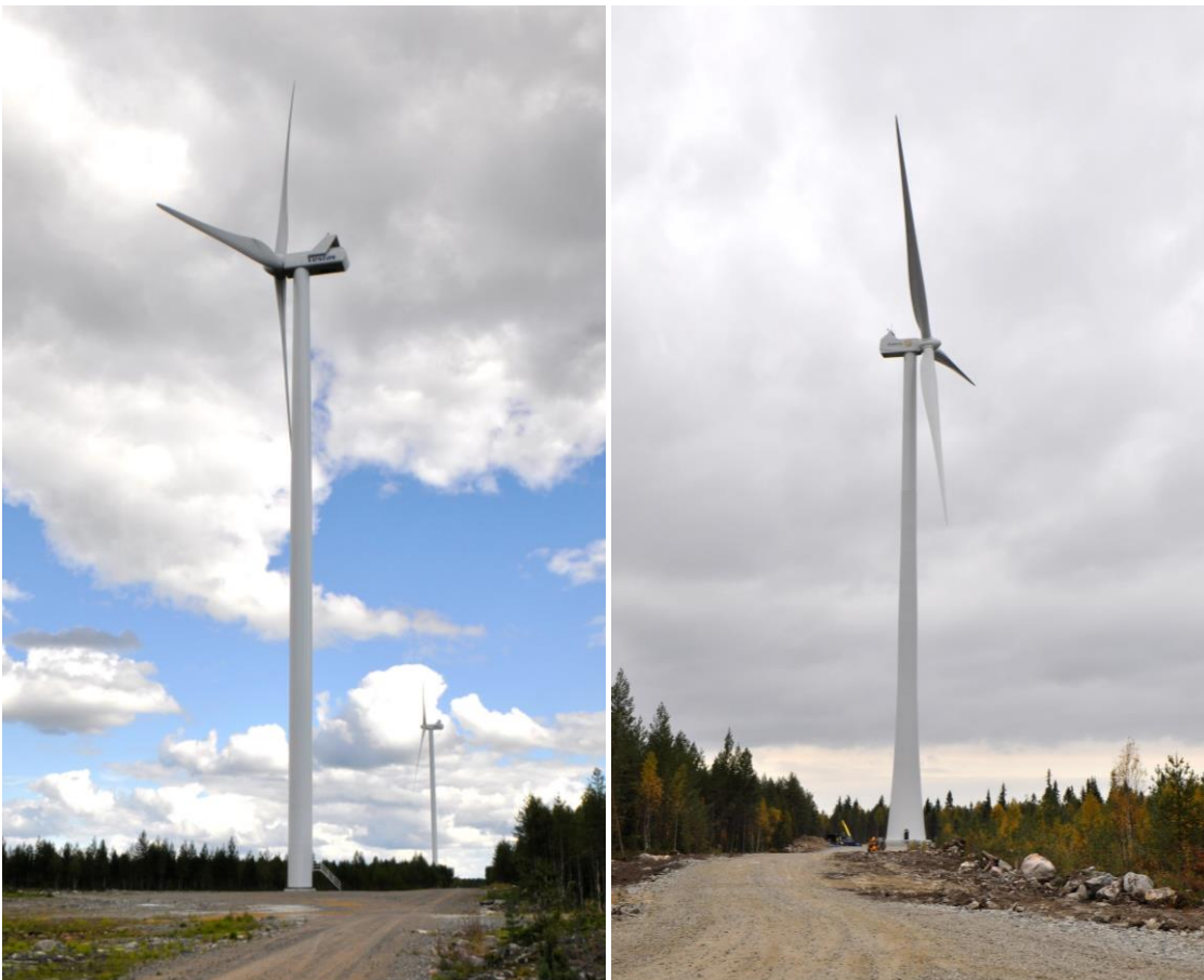
Kuva 4.4. Vasemmalla teräslieriötorni ja oikealla rakenteilla oleva hybriditorni (Kuvat: Leila Väyrynen, FCG).
