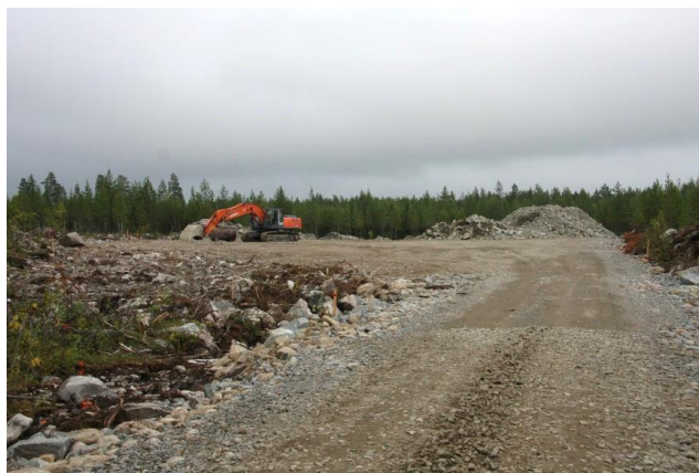
Kuvapari 4.12. Tuulivoimapuiston rakentaminen alkaa huoltoteiden ja pystytysalueiden rakentamisella (kuvat: Ville Suorsa/FCG).
