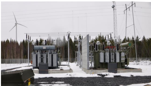
Kuvapari 4.11. Esimerkkikuvia tuulivoimapuiston 110/20 kV sähköasemasta. (Kuva: Leila Väyrynen/FCG).
