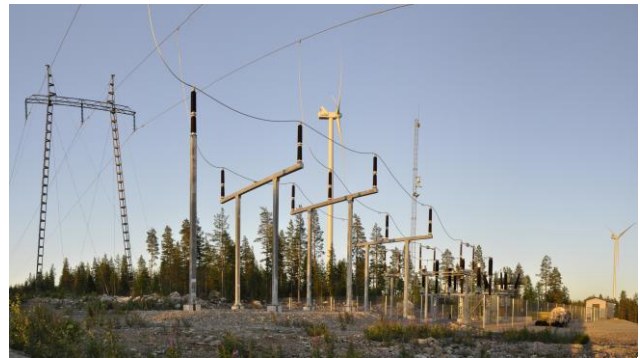
Kuvapari 4.11. Esimerkkikuvia tuulivoimapuiston 110/20 kV sähköasemasta. (Kuva: Leila Väyrynen/FCG).
