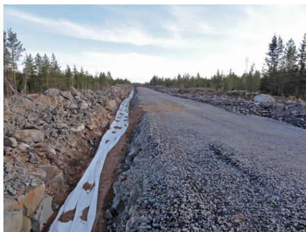
Kuvapari 4.13. Maakaapelit upotetaan huoltoteiden yhteyteen (kuvat: Ville Suorsa/FCG).
