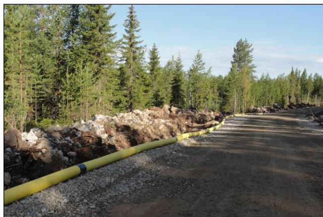
Kuva 4.9. (Vasemmalla) Esimerkki tuulivoimapuiston rakennus- ja huoltotiestä. Teitä käytetään muun muassa betonin, soran ja voimaloiden komponenttien kuljetuksiin sekä tuulivoimapuiston käyttövaiheessa huoltoajoihin. Maakaapeli sijoitetaan ojakaivantoon tien reuna-alueelle (Kuva: Ville Suorsa / FCG).
