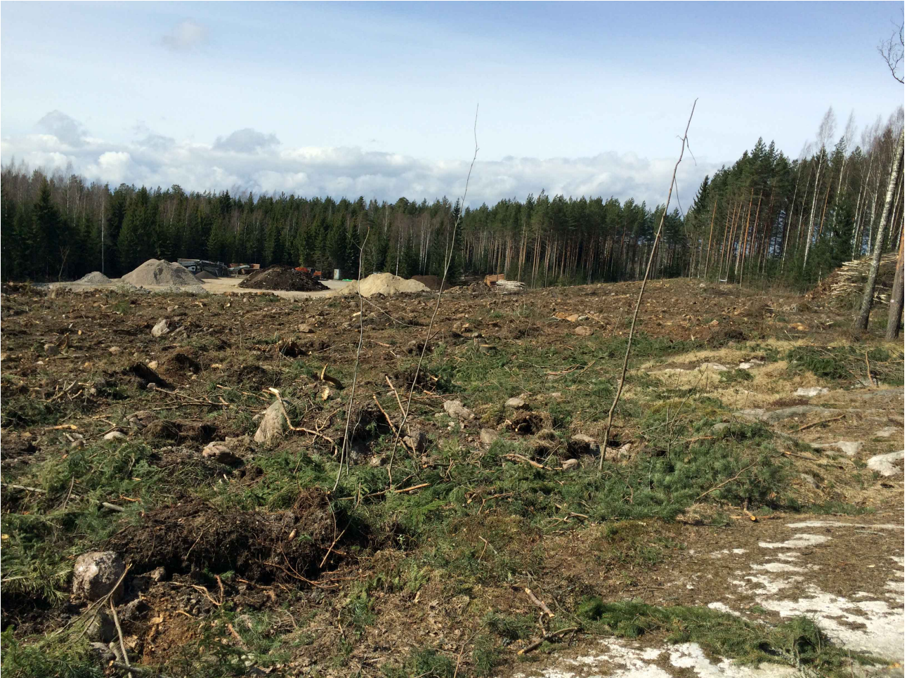
Kuva 3. Hankealueen puustoa on poistettu ja varastokenttää rakennettu hankealueen länsiosassa. Kallio nousee, paikoin avokalliona, kohti Tuusulan rajaa. Hankealueen eteläosa on ojitettua, märkää metsämaata.
