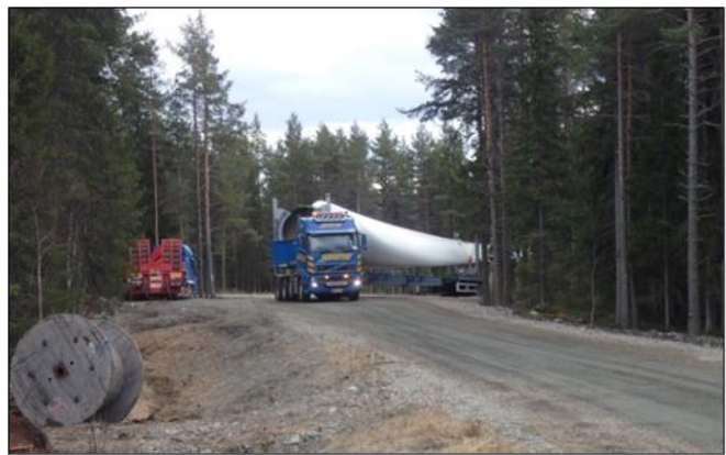
Kuva 80. Vasemmalla kuvassa on esimerkki tuulivoimapuiston rakennus- ja huoltotiestä. Teitä käytetään muun muassa betonin, soran ja voimaloiden komponenttien kuljetuksiin sekä tuulivoimapuiston käyttövaiheessa huoltoajoihin. Maakaapeli sijoitetaan ojakaivantoon tien reuna-alueelle. Oikealla kuvassa tuulivoimalan osia kuljetetaan erikoiskuljetuksina. (Kuvat: Ville Suorsa / FCG).
