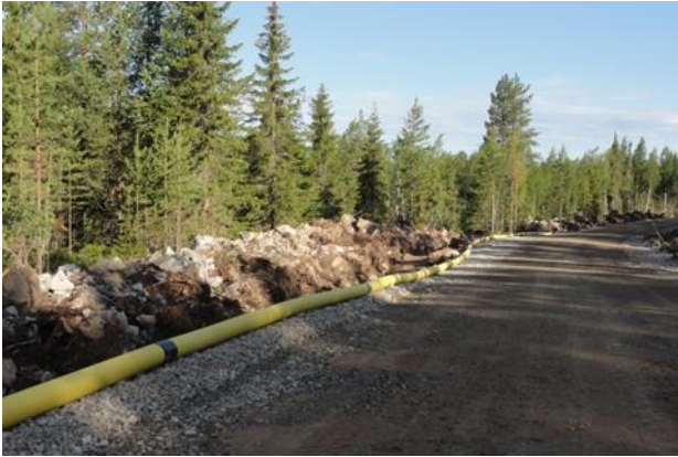
Kuva 80. Vasemmalla kuvassa on esimerkki tuulivoimapuiston rakennus- ja huoltotiestä. Teitä käytetään muun muassa betonin, soran ja voimaloiden komponenttien kuljetuksiin sekä tuulivoimapuiston käyttövaiheessa huoltoajoihin. Maakaapeli sijoitetaan ojakaivantoon tien reuna-alueelle. Oikealla kuvassa tuulivoimalan osia kuljetetaan erikoiskuljetuksina. (Kuvat: Ville Suorsa / FCG).
