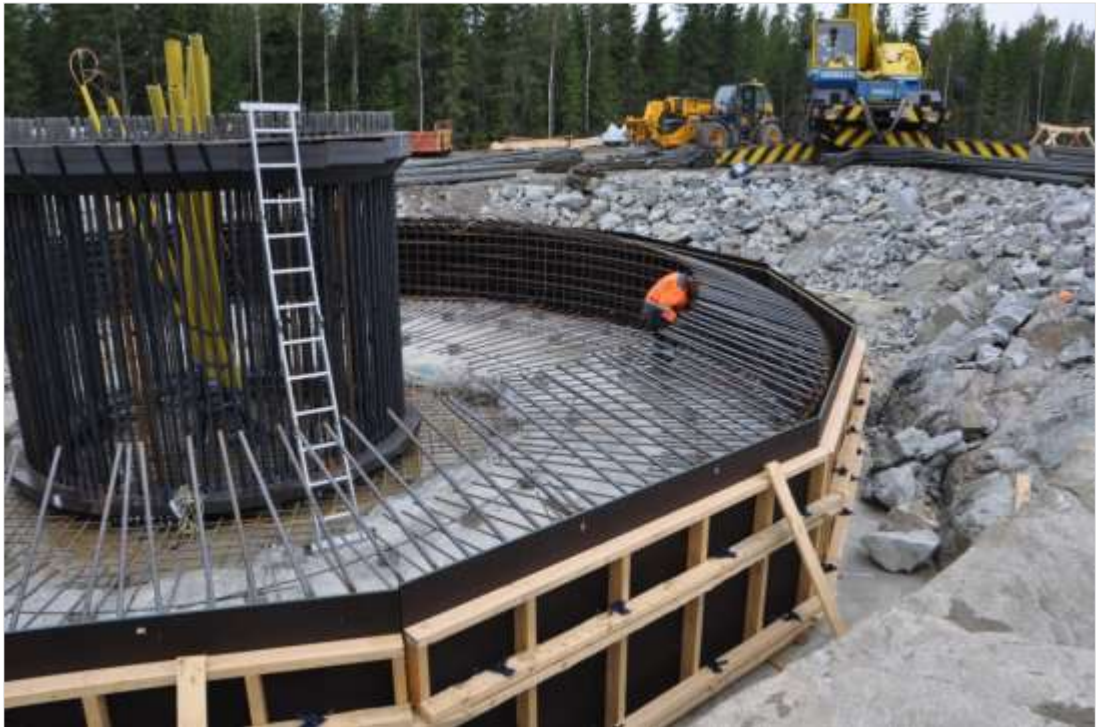
Kuva 5.10. Tuulivoimalan perustusten rakentamista. Kuva: Leila Väyrynen/ FCG
