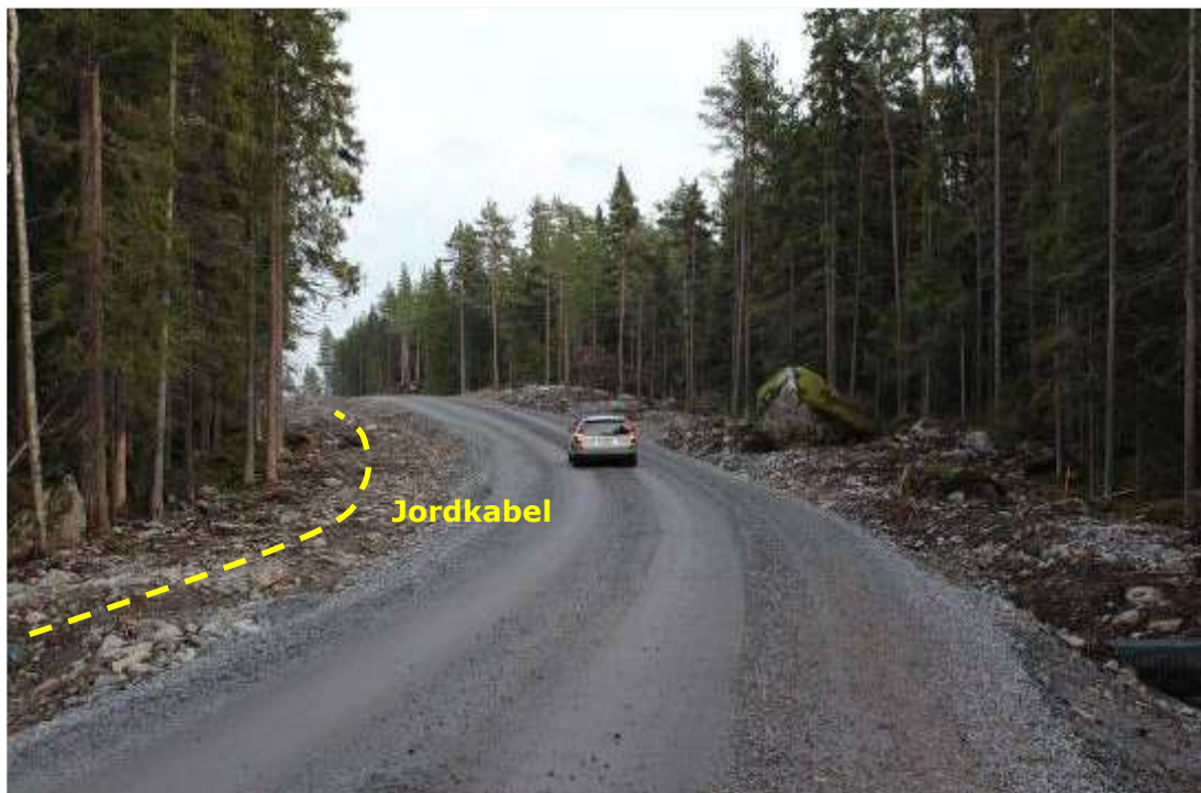
Bild 5.5. Exempel på bygg- och serviceväg för vindkraftsparken. Jordkabeln har dragits på vänstra sidan av vägen. Foto: Hans Vadbäck/FCG
