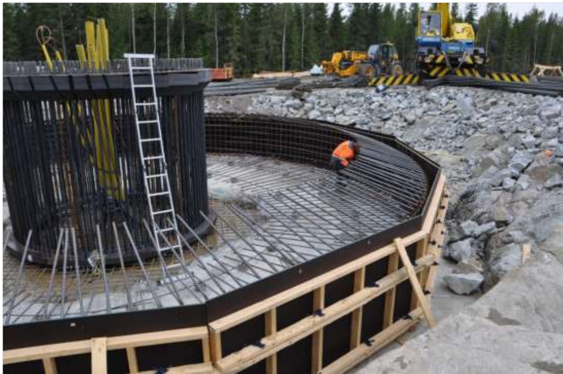
Bild 5.10. Anläggning av ett vindkraftsfundament. Foto: Leila Väyrynen/FCG
