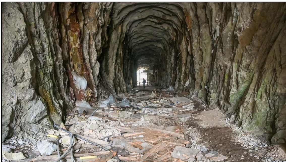
Salo Tunnelimäki. Tunneli sisältä. Kuva lännestä. (AKDG6006:2)
