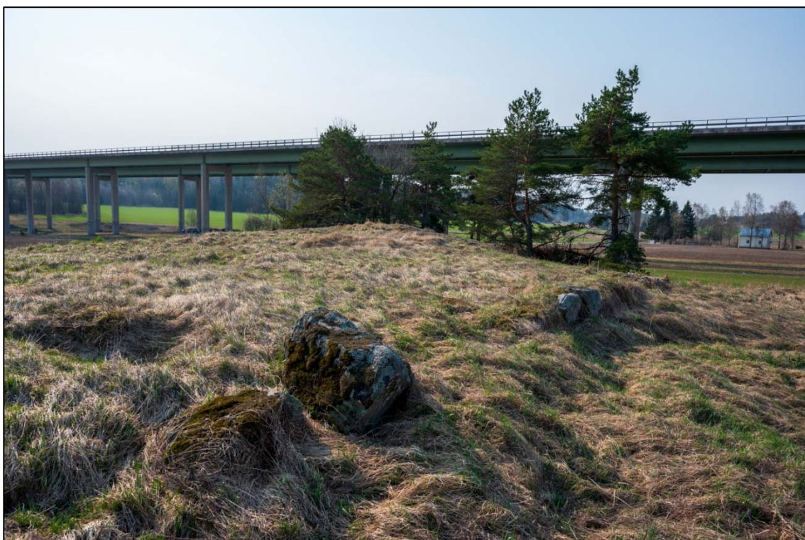
Kaarina Skänkilä. Rakennuksen perustaa peltosaarekkeella. Kuva pohjoisesta. (AKDG6021:1)
