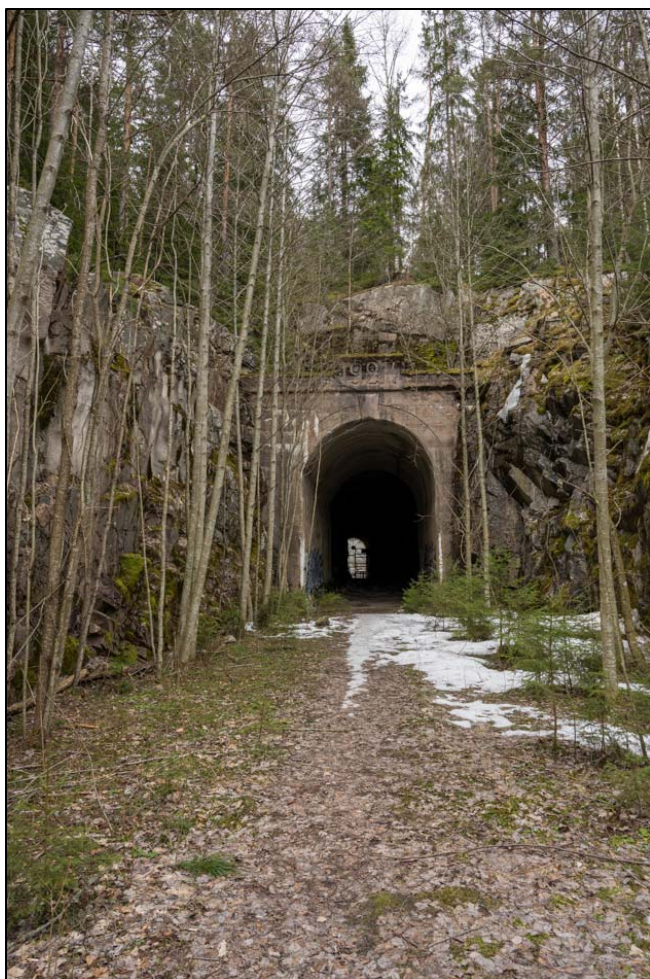
Salo Tunnelimäki. Vuonna 1927 valmistuneen rautatietunnelin suuaukko. Kuva lännestä. (AKDG6006:1)
