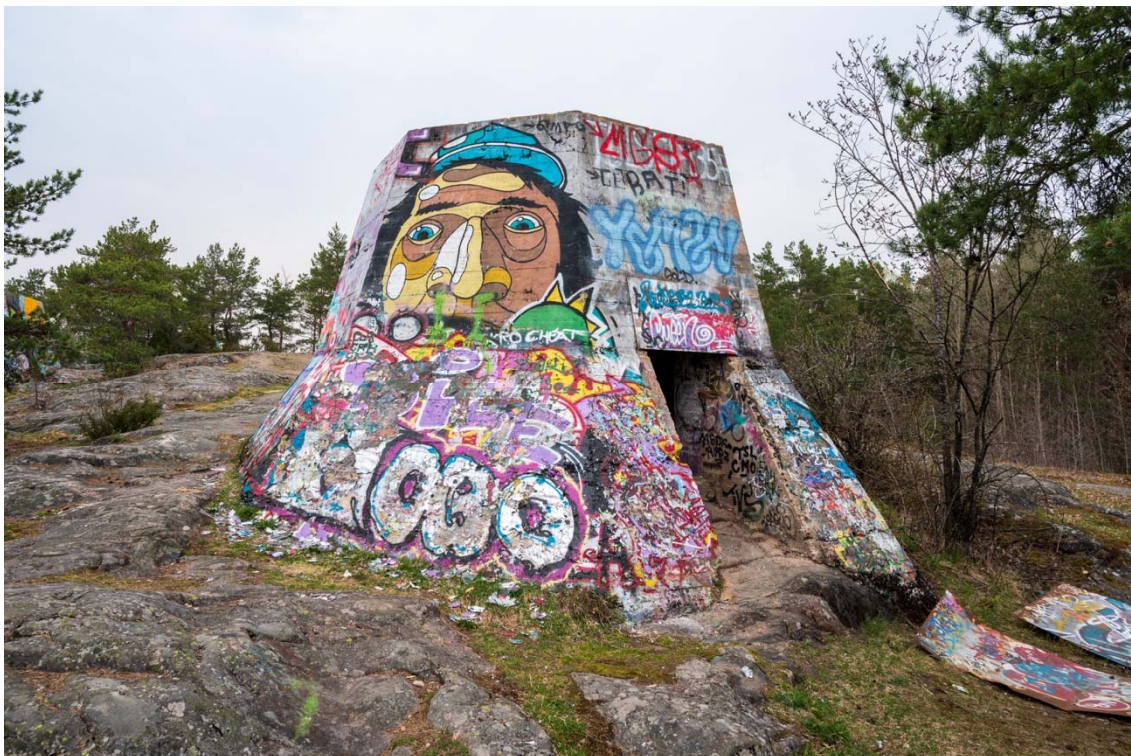
Turku Mikkolanmäki. Betonoidut puolustusvarustuksiin on maalattu paljon graffiteja. Kuva etelästä. (AKDG6025:1)
