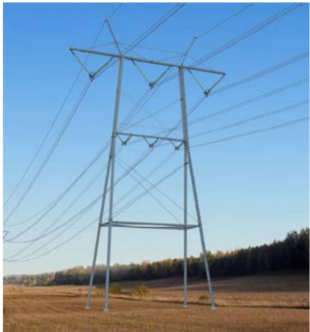
Kuva 10. Harustamaton 400 +110 kV portaalipylväs (havainnekuva).
