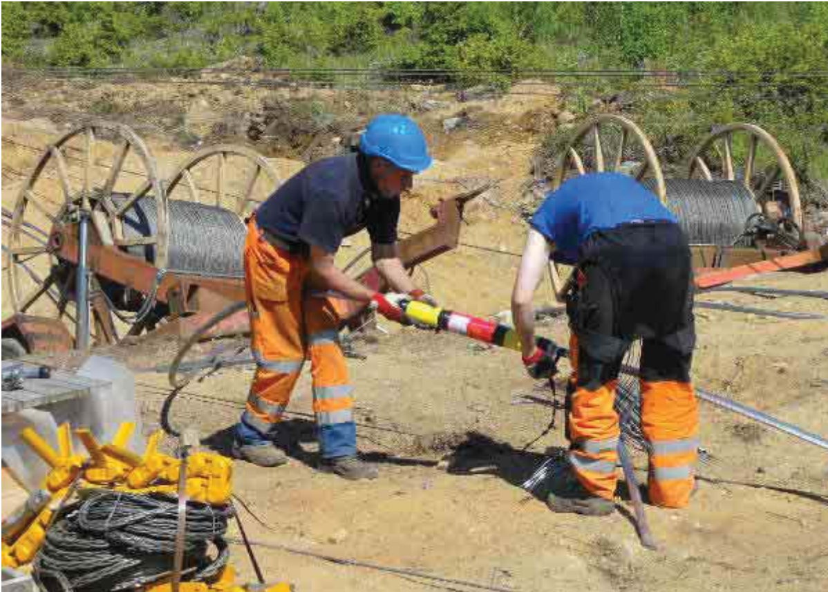
Kuva 152. Voimajohtojen johdinten liittämiseksi käytetään räjäytettäviä liittoksia.
