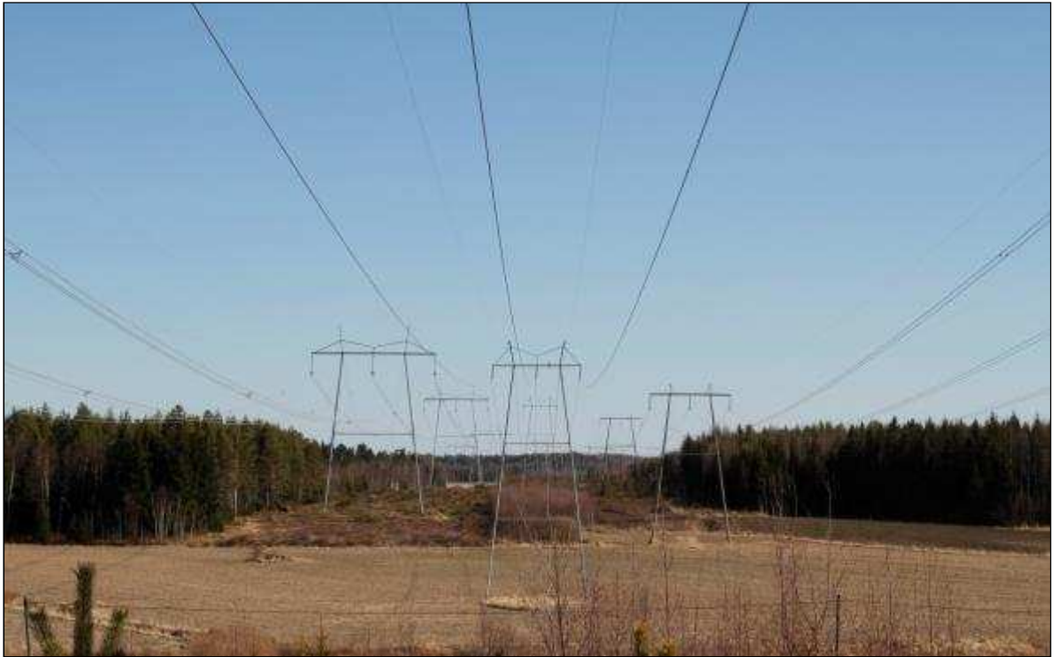
Kuva 11.2. Hankealueen eteläosan voimajohtoalue.
