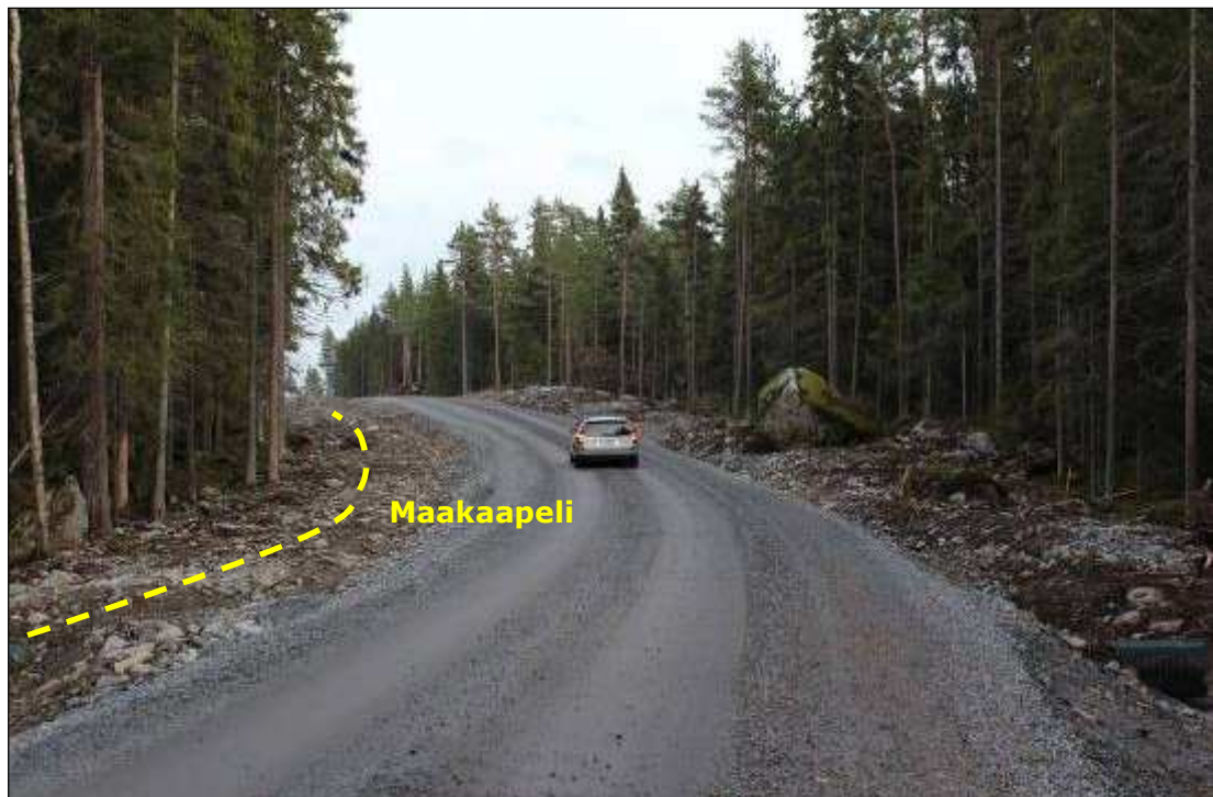
Kuva 5.4. Esimerkki tuulivoimapuiston rakennus- ja huoltotiestä. Maakaapeli on asennettu tien vasemmalle puolelle (kuva: Hans Vadbäck / FCG).
