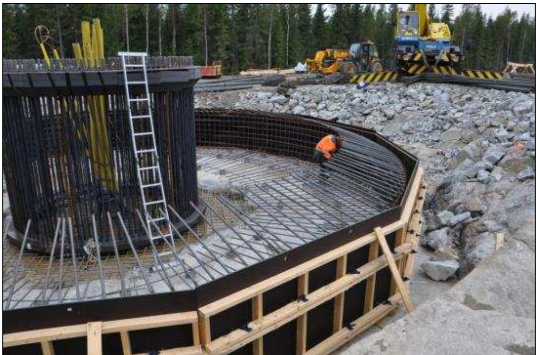
Kuva 5.8. Tuulivoimalan perustusten rakentamista (kuva: Leila Väyrynen, FCG).
