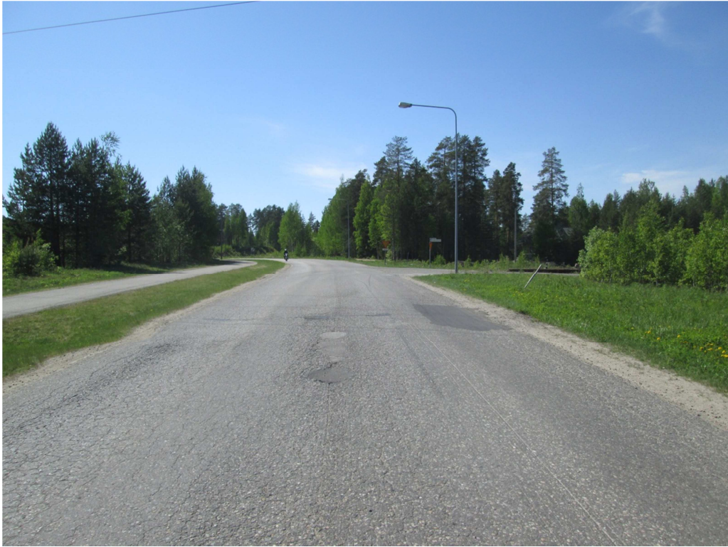
Valokuva 2. Pitkänmäentie Voimatien liittymästä Kuopiontielle päin.
