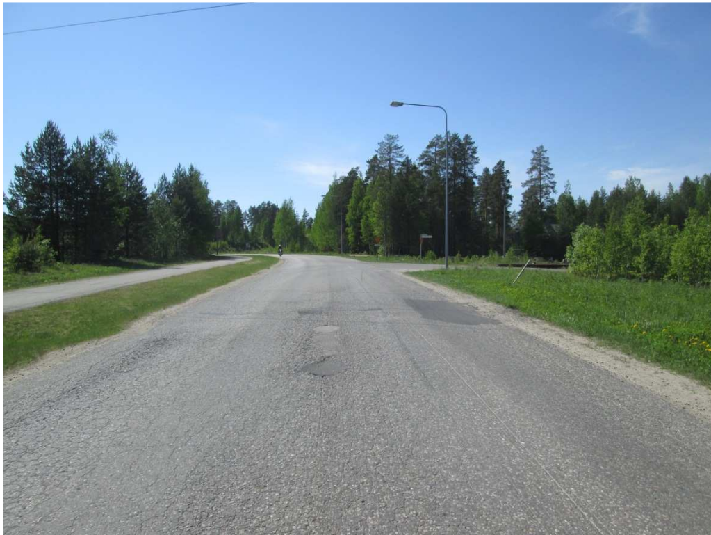
Valokuva 2. Pitkänmäentie Voimatien liittymästä Kuopiontielle päin.
