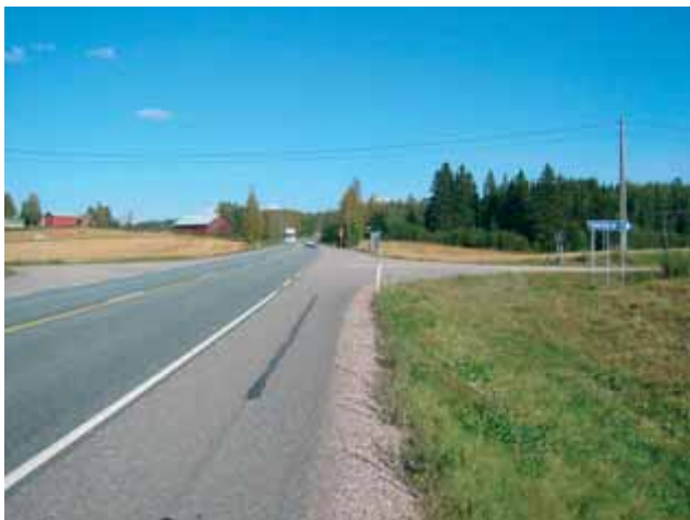
■ Kuva 6.26. Koskimyllyn paikallistien ja kantatien 54 liittymä etelästä päin kuvattuna.
