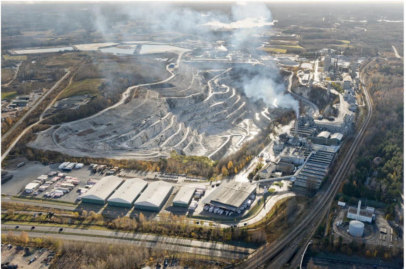
Kuva 7.2-2. Ilmakuva Ihalaisen avolouhoksesta pohjoisen suunnalta kuvattuna (kuvattu 25.10.2012)
