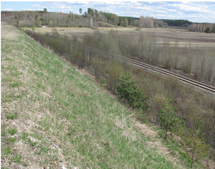
Kuva 12.4-1. Nykyisen käytössä olevan rikastushiekka-alueen reunapadon maisemoitua luiskaa. Kuvassa oikealla näkyy Mustolan rataa sekä sen eteläpuoleisia peltoalueita.
