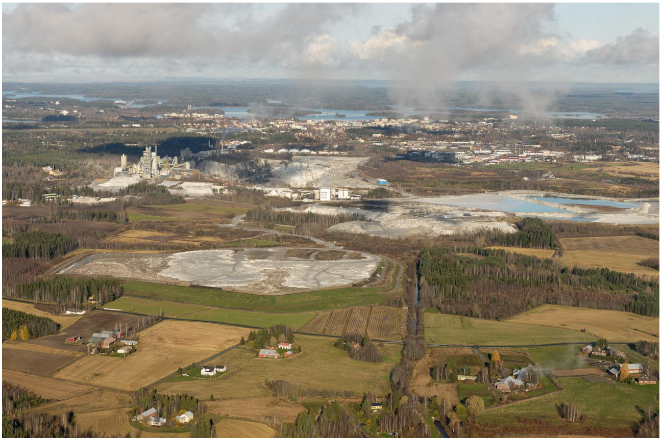
Kuva 7.9-1. Nykyinen lounainen sivukivien ja maanpoistomassojen läjitysalue (kuvassa keskellä, vasemmalla). Kuvan oikeassa reunassa rikastushiekka-alue, sen vasemmalla puolella sivukiven välivarasto- ja käsittelyalue sekä taustalla Ihalaisen avolouhos ja tehdasalue.
