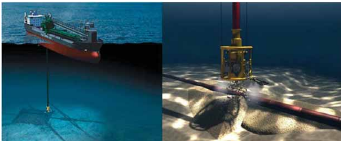
Kuva 4-8. Kiviaineksen kasaus merenpohjaan laskuputken avulla. Kuva: Nord Stream AG.
