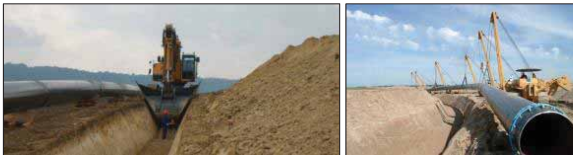
Kuva 6-21 Putkikaivantoa kaivetaan maalla (vasemmalla) ja putki lasketaan kaivantoon.
