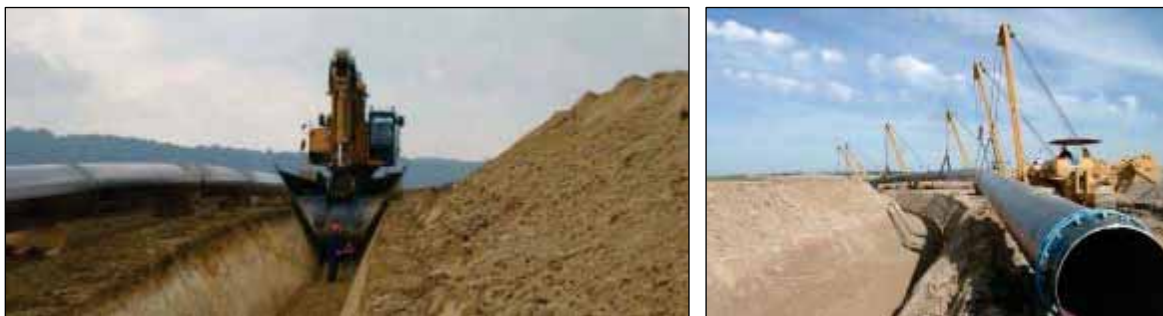
Figur 6-21 Grävning av rörledningsdike på land (till vänster) och rörledning som sänks ner i diket.
