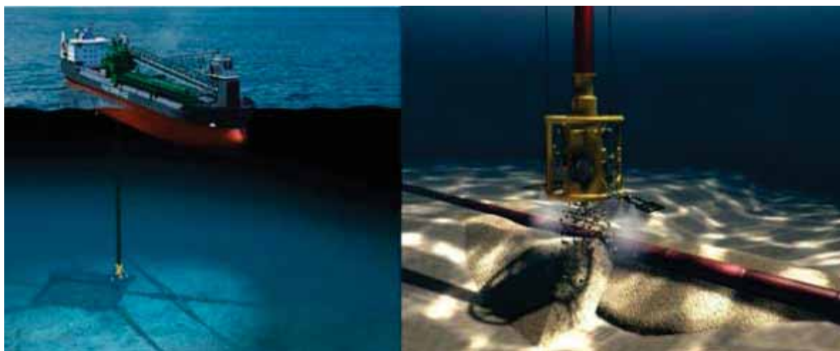
Figur 6-17 Stenläggning på havsbotten via fallrör.
