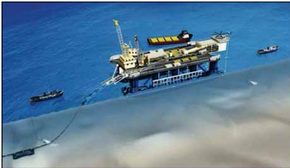
Figur 6-11 S-rörlägningsfartyg med undersöknings- och stödfartyg.
