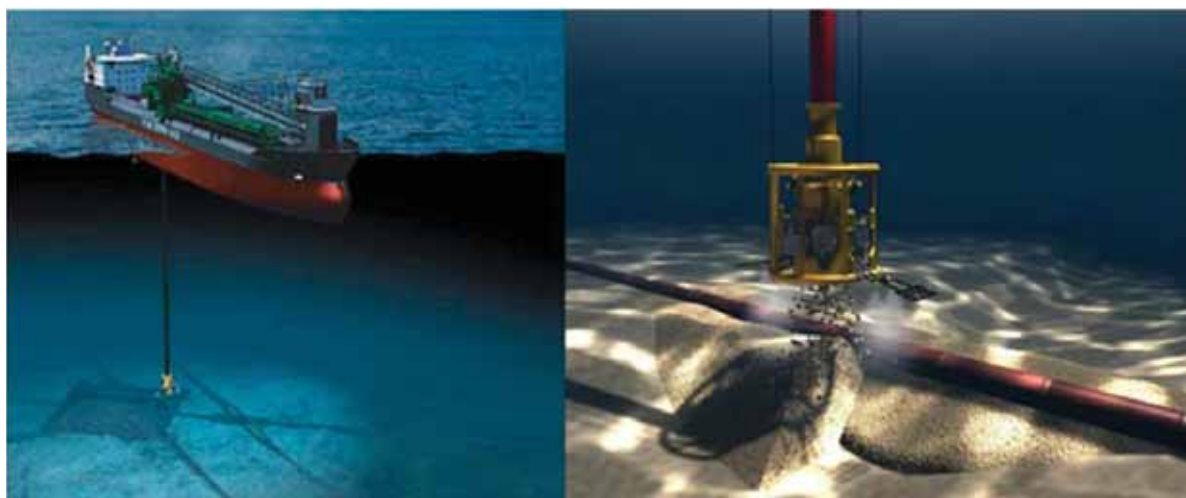
Figur 4-8. Stenläggning på havsbotten genom ett fallrör. (Bilder: Nord Stream AG)
