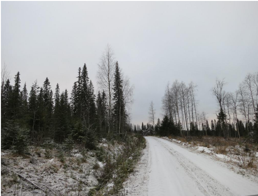
Kuva 4-8. Esimerkki tuulipuiston rakennus- ja huoltotiestä. (Kuva: Pöyry)
