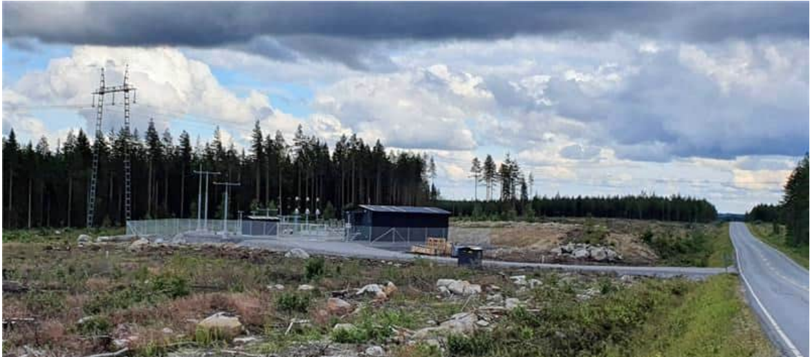
Kuva 4-6 Esimerkkikuva johdonvarsiliitännästä 110 kV ilmajohtoon.
