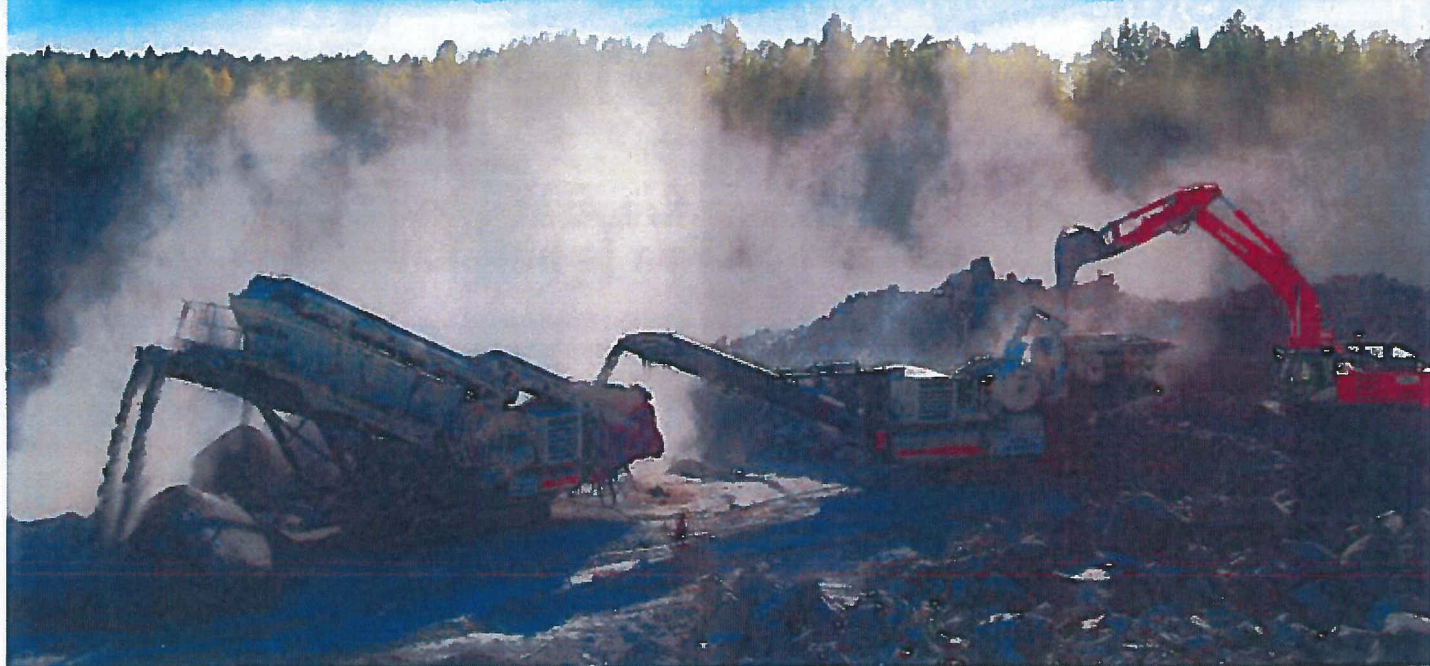
Esi- ja jälkimurskaamisen sisältävän laitoksen etuja ovat joustavuus sekä helppo siirrettävyys ottoalueelta toiselle.
