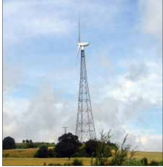
Kuva 2-6 Ristikorakenteinen torni.
