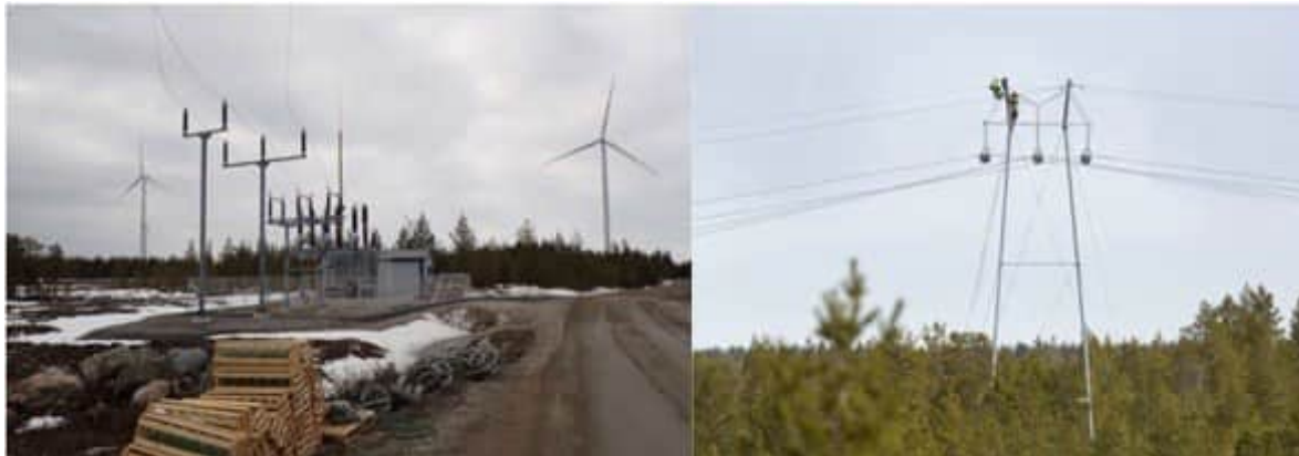
Kuva 5.15 Sähkösäntä ja voimajohdon rakentamista (FCG).
