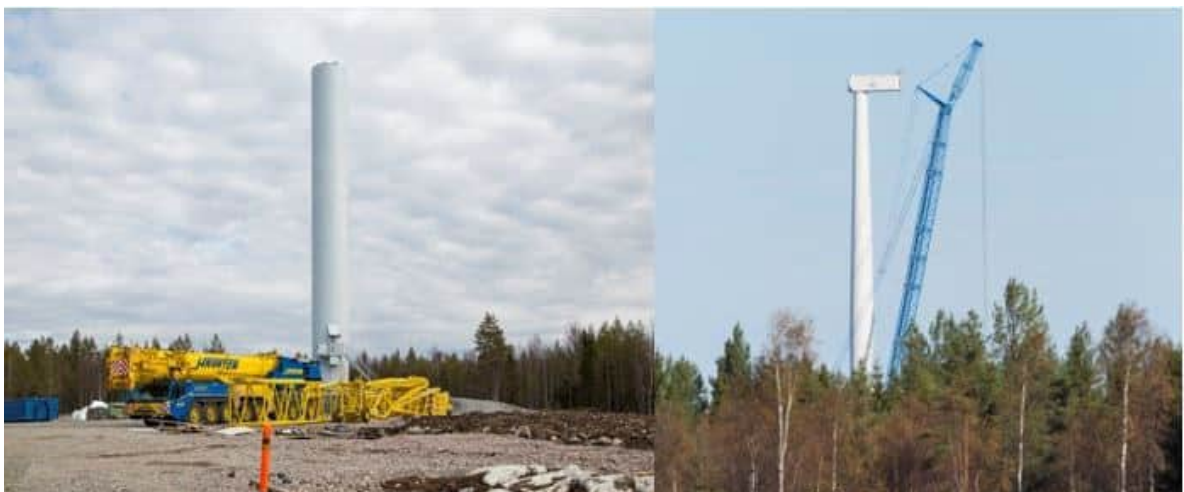
Kuva 5.13 Tuulivoimalan kokoamista (FCG).
