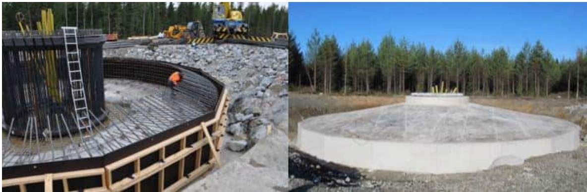
Kuva 5.12 Tuulivoimalan perustusten rakentamista (FCG).
