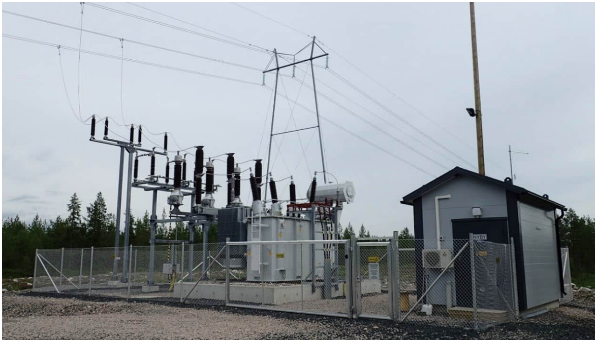
Kuva 5.8 Esimerkki tuulivoimapuiston sähköasemasta (FCG).
