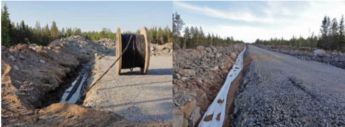
Kuva 5.11 Maakaapelit upotetaan huoltoteiden yhteyteen (FCG).
