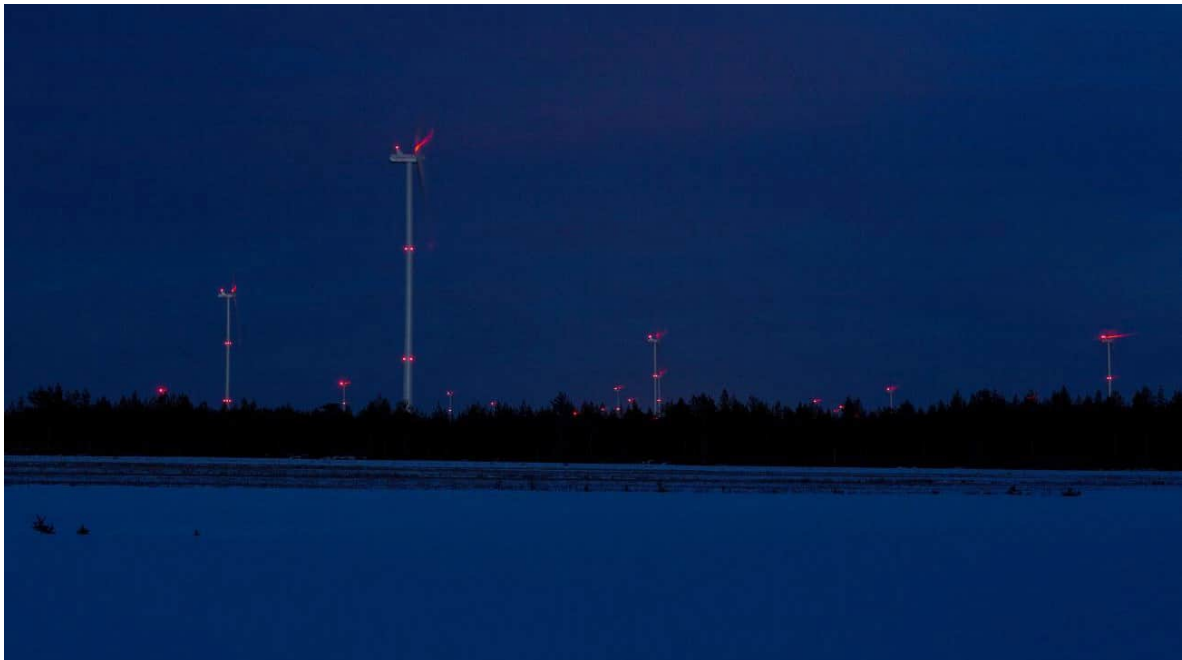
Kuva 5.5 Kiinteät punaiset lentoestevalot (FCG).
