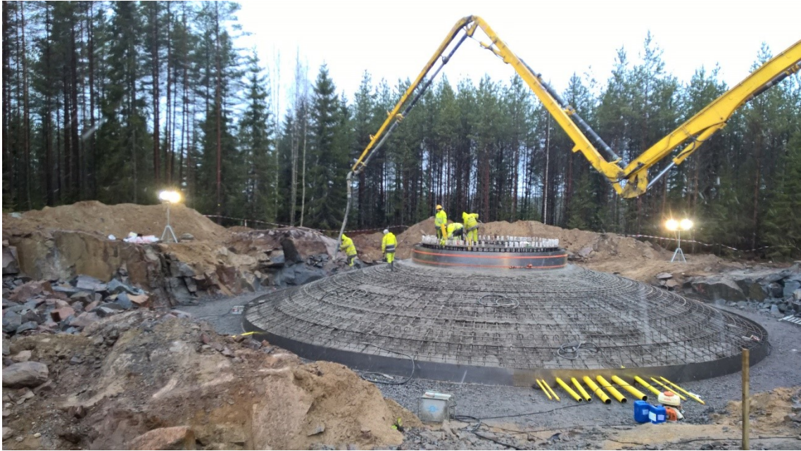
Kuva 3.4. Esimerkkikuva tuulivoimalan perustusten rakentamisesta.
