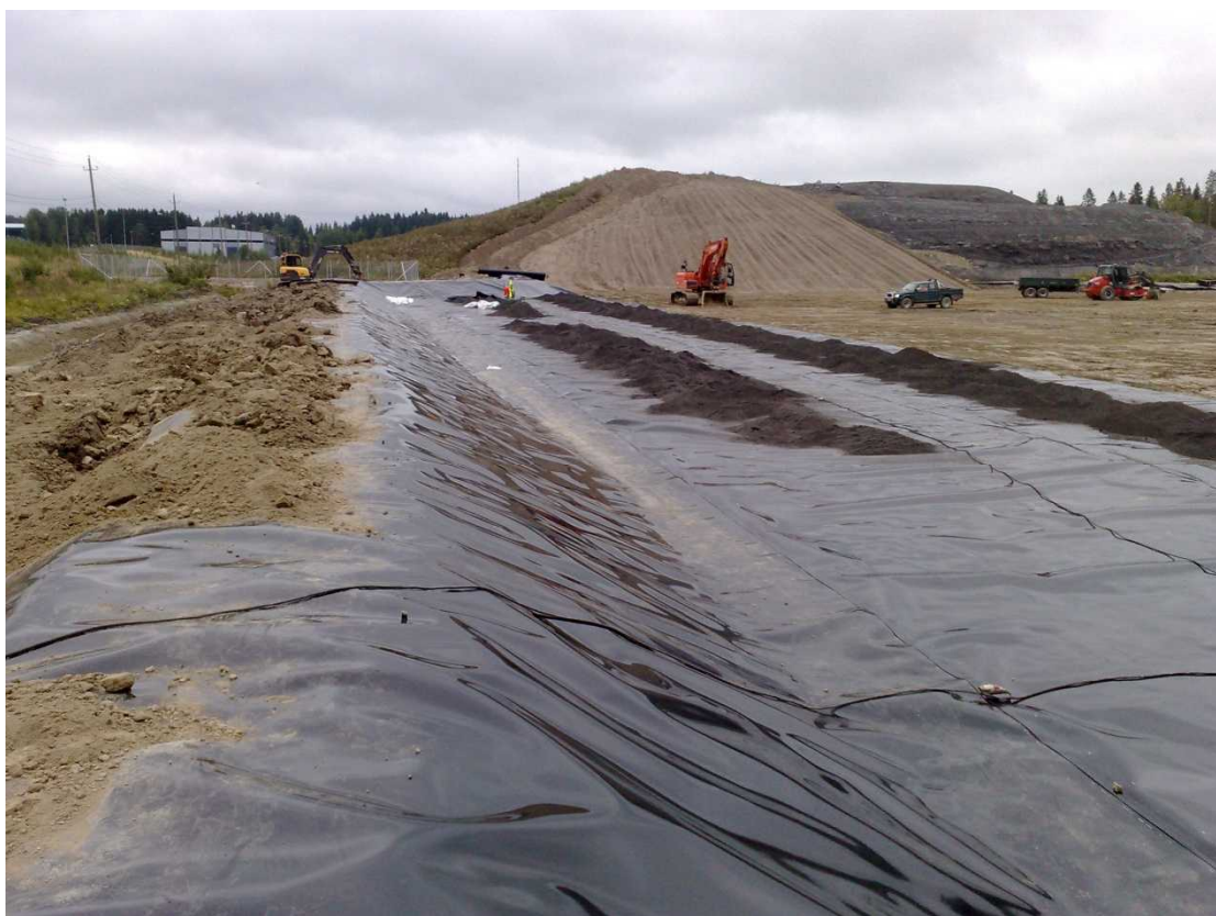
Kuva 4-10. Esimerkkikuva tavanomaisen jätteen loppusijoitusalueen rakentamisesta. Kuvassa muovikalvo asennettu maabentoniin päälle.
