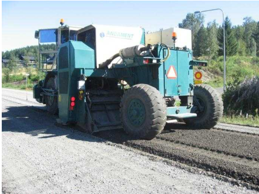
Kuva 3-19 Kuvassa esimerkki tuhkan hyötykäytöstä tierakenteessa käyttäen kerrosstabilointitekniikkaa
