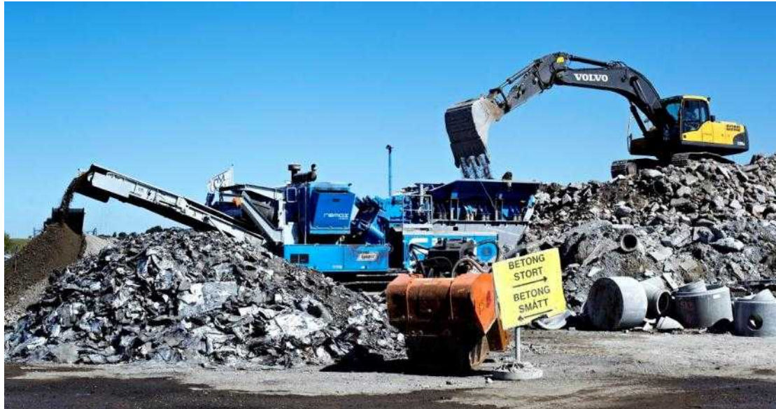
Kuva 3-18 Kuvassa on esimerkki betonijätteen murskauksesta
