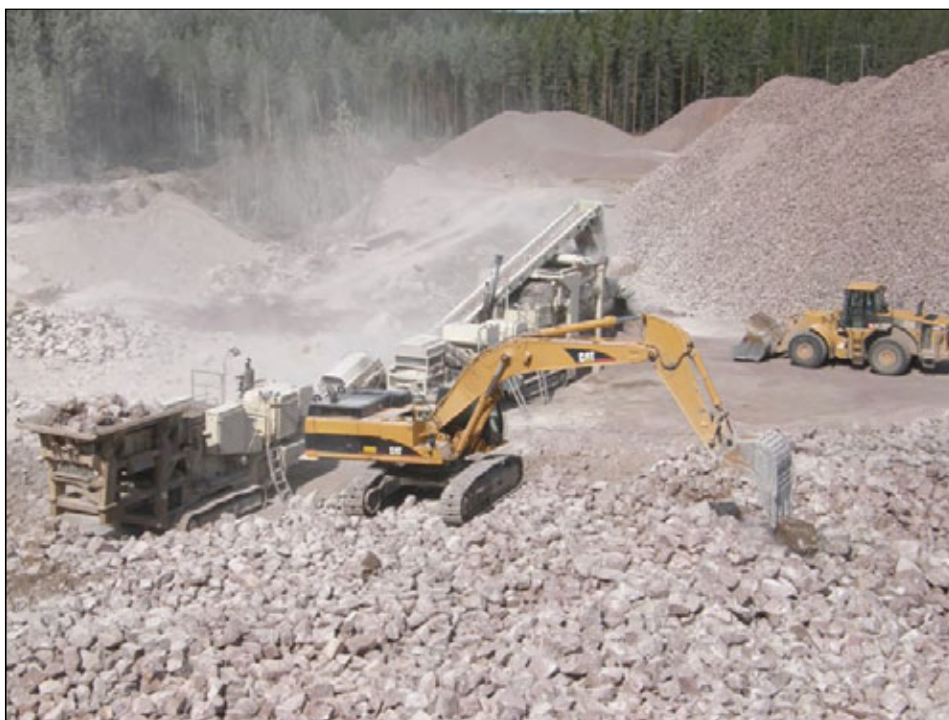
Kuva 3.8. Kolmevaiheinen kivenmurskauslaitos, etualalla laitosta syöttävä kaivinkone, oikealla mursketta siirtävä etukuormaaja. Taustalla murskeen varastokasoja.
