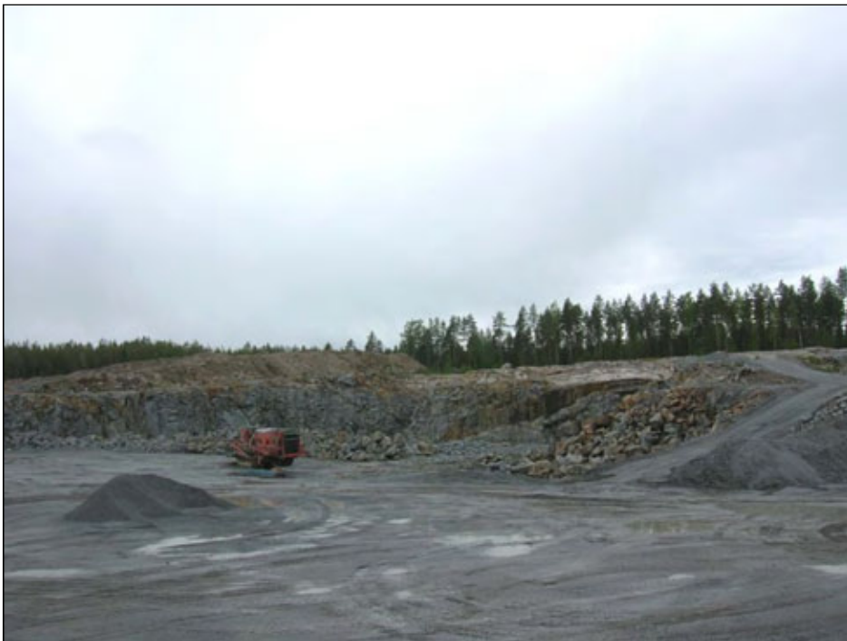
Kuva 4.1. Näkymä etelän suunnasta hankealueen tilalle Korpela 13:1, jossa jo kiviaineksen otto käynnissä
