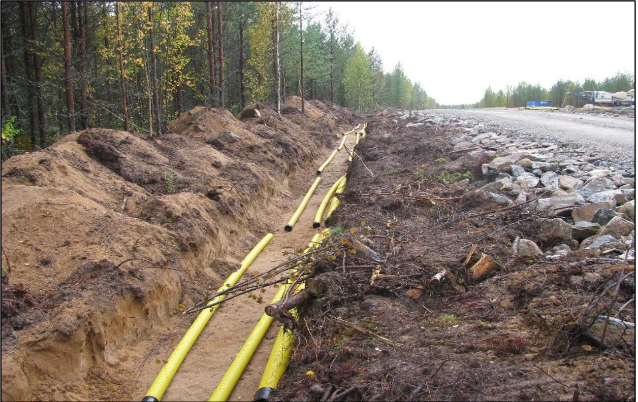
Kuva 15. Maakaapeleiden asennus erillisen kaapeliojaan tien sivuun (Myrsky Energia Oy).
