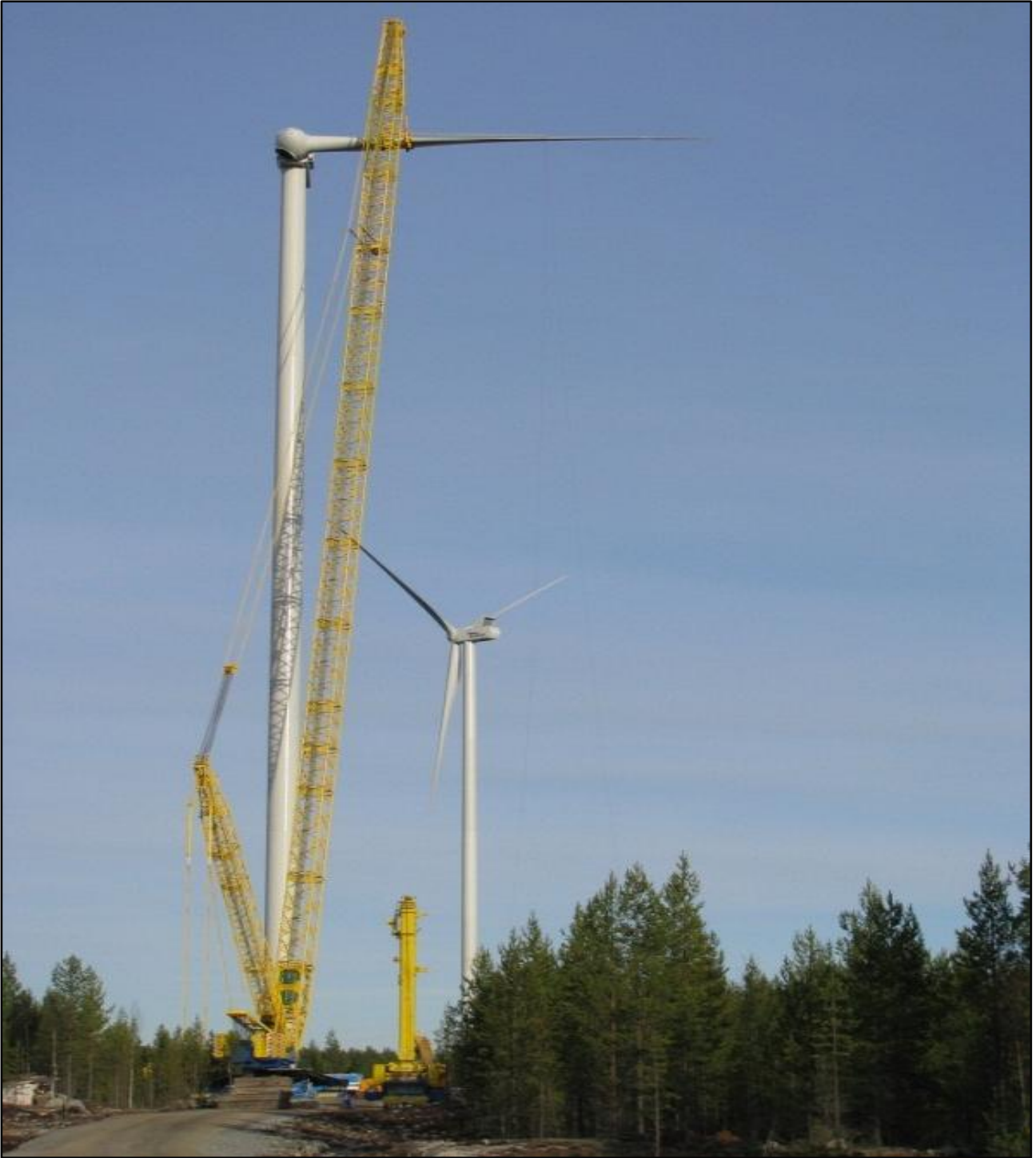
Kuva 24. Tuulivoimalat kootaan valmiiksi rakentamisaikalla (Myrsky Energia Oy)
