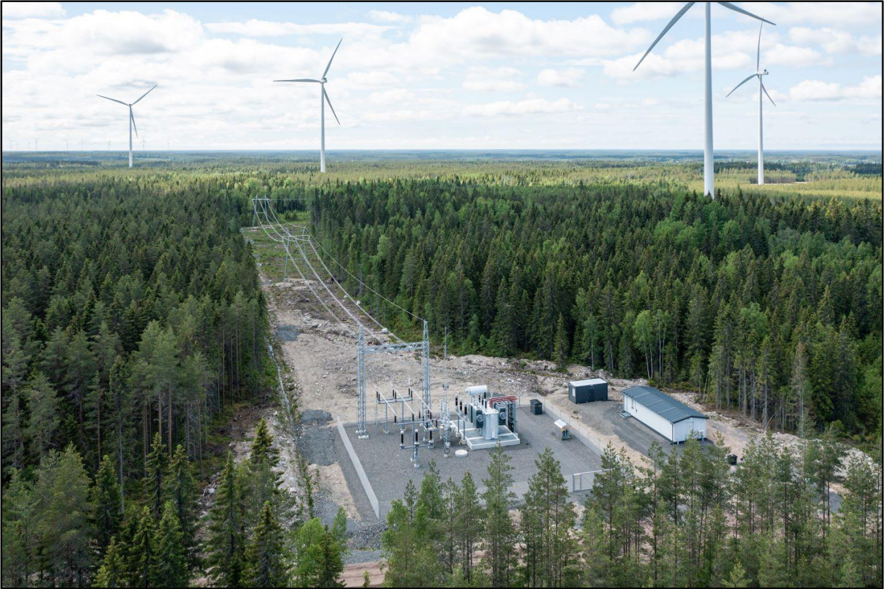
Kuva 19. Esimerkkikuva sähkönsiirrosta hankealueen sähköasemalta alkaen. Kuvan sähkönsiirto 400 kV voimajohtolla, Miilukankaan hankkeessa suunnitellaan 110 kV voimajohtoa.
