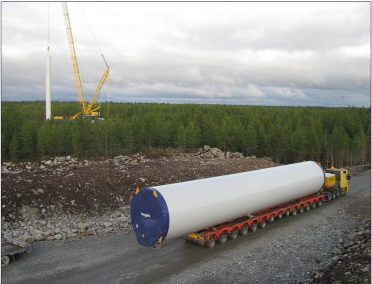
Kuva 23. Voimalat kuljetetaan rakentamispaikoille osissa (Myrsky Energia Oy)
