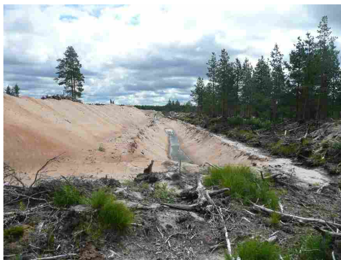
Kuva 4. Kohteen eteläpuolelle rämeen reunalle kaivettu kuivatusoja.
