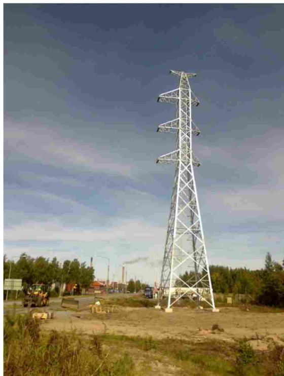
Kuvat 4 ja 5. Vapaasti seisova teräsristikkopylväs (4T-pylväs), (Ramboll Finland Oy, TLT Eng. 2013).
