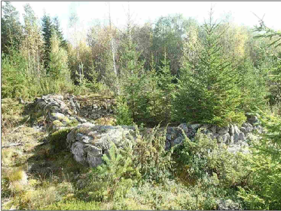
Kuva 22. Hirvimaan historiallisen ajan kivirakenteinen rakennuksen perustus voimajohtoreitin alkupäässä Kalajoen kaupungin alueella (Mikroliitti Oy 2013).
