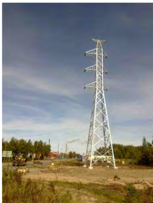
Kuvat 9. Vapaasti seisova teräsristikkopylväs (4T-pylväs), (Ramboll Finland Oy, TLT Eng. 2013).
