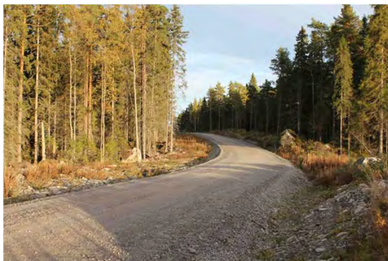
Kuva 16. Tuulivoimalan huoltotie – Öjen, Vaasa (Ramboll Finland Oy 2013).
