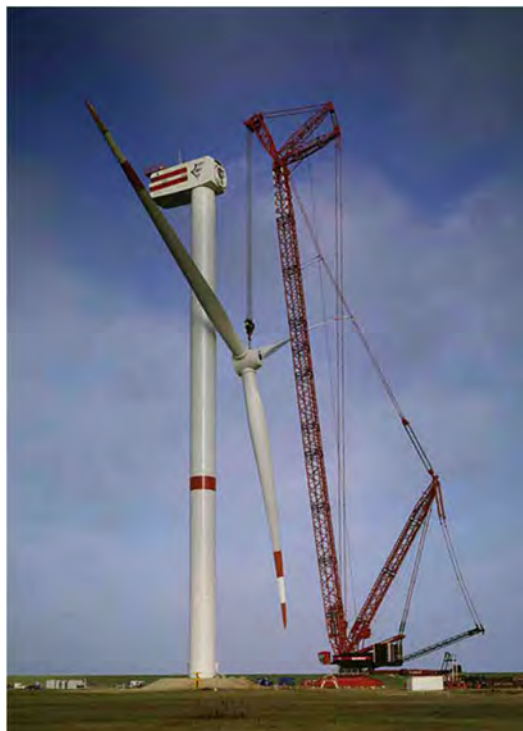
Kuva 21. Tuulivoimalan pystytys tela-alustaisella nosturilla (Liebherr).
