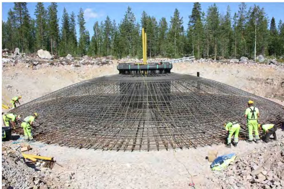
Kuva 12. Maanvarainen teräsbetoniperustus raudoitettuna ennen betonivalua, Tervola (Ramboll Finland Oy 2013).
