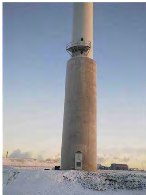
Kuva 13. Hybriditorni, Tornio (Ramboll Finland Oy).
