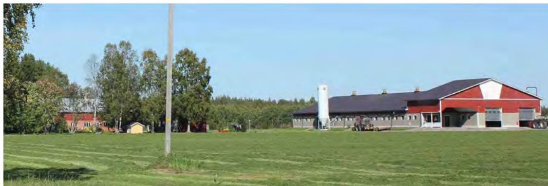
Kuva 43. Pohjantähti -kiinteistön navettarakennus Mutkalammilla. © Erika Kylmänen.
