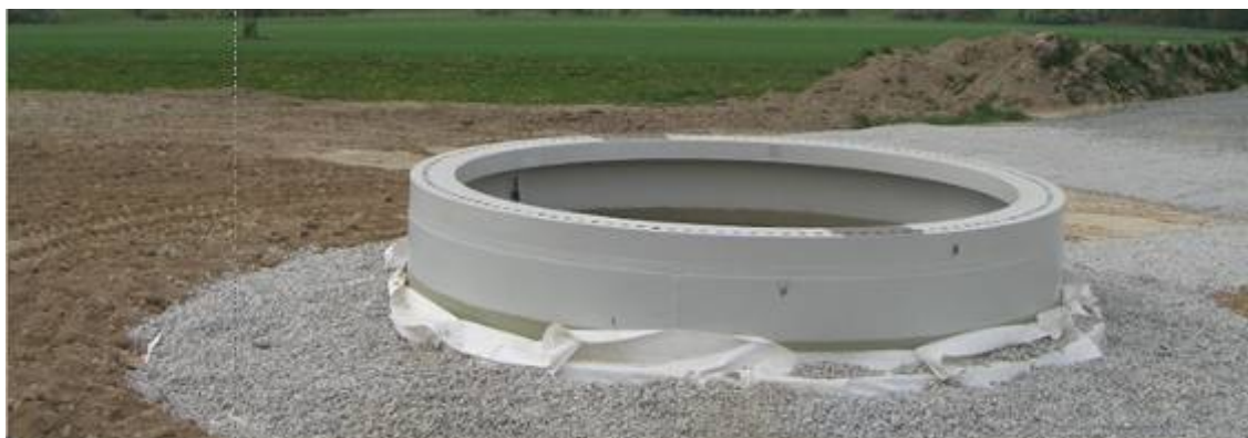
Kuva 3-6. Perustuksen rakentamismvaiheita (Kuva © Ventureal)
